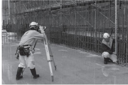
右/朝礼を終え、現場へ。設計図通りに施工されているか、測量をして確認する。
