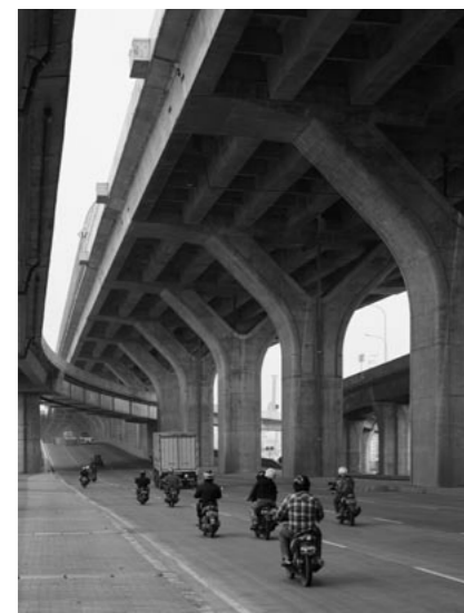
大型Y型橋脚及びランプ交差部 (2016年3月)
