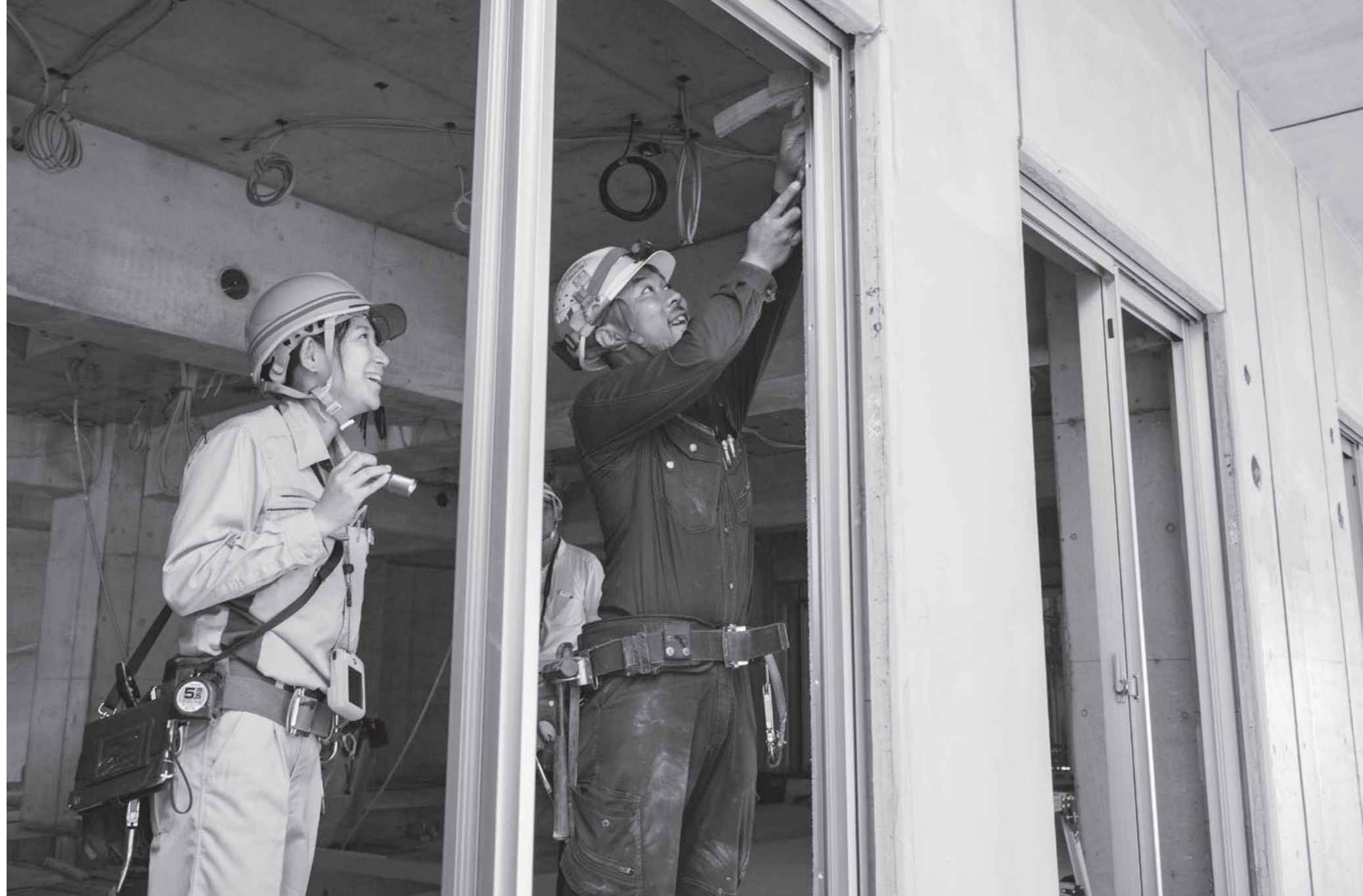
窓まわりには、溶接せずにアルミサッシを固定する工法を用いている。火気の発生がないため、より安全に工事を進められる。「忽滑谷さんはわれわれの司令塔です」とサッシの職人も顔をほころばせた。
