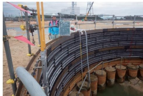
土留め、止水をより確実にするため、施工スペースを包囲するライナープレートを設置した(提供: あおみ建設株)。
