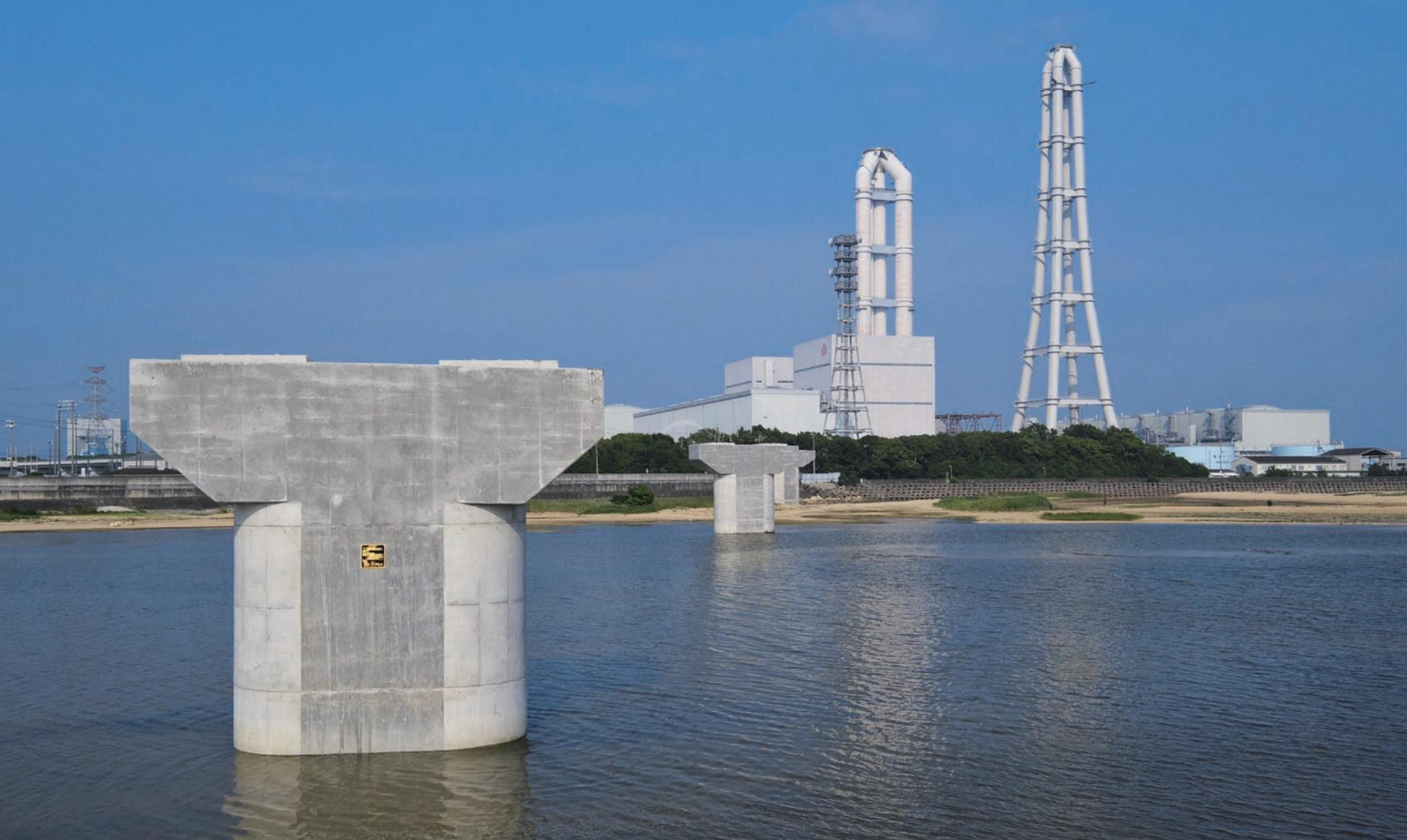
三基の橋脚が完成、橋桁の架設を待っている。橋梁の完成により市街地における渋滞緩和、物流機能の向上が期待される。とはいえ現場周辺は市民の憩いの場となる貴重な干潟だ。施工中は迂回路の整備など海岸利用者の動線確保に重点が置かれた。
