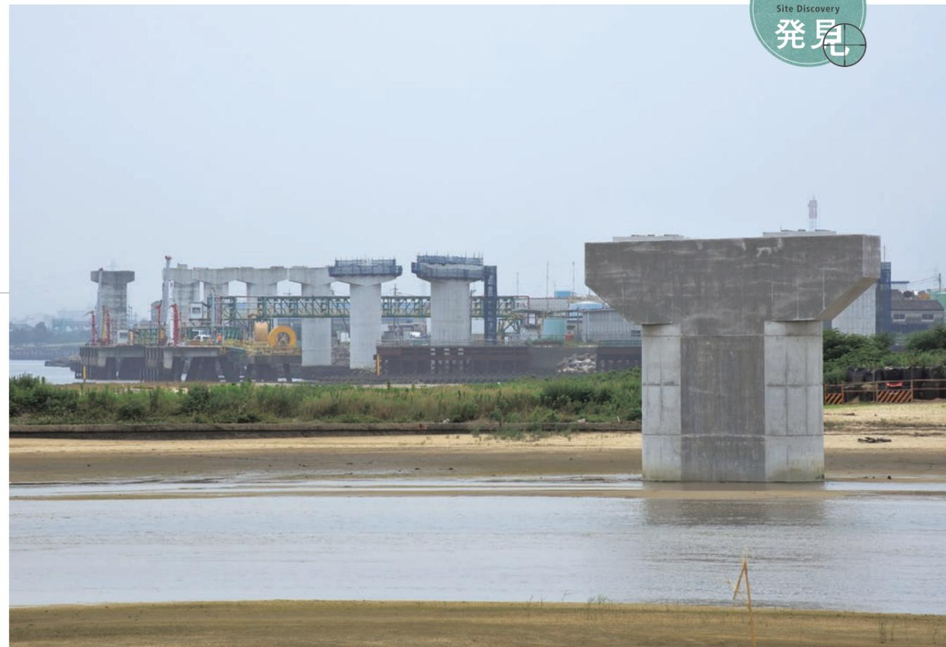
橋脚の構築に採用されたのはマスコンクリート。構造的な強度を確保できる一方、ひび割れが発生しやすい扱いの難しさもあるが技術提案によりこれを克服。コンクリートの打設、品質管理には細心の注意が払われた。
