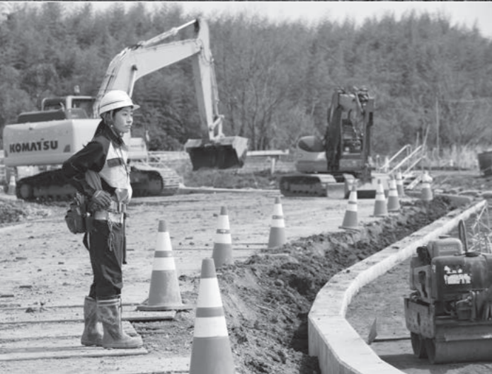
上/堤防樋管改築工事の現場全景。 下/現場全体を管理している小笠。各所の安全確認を徹底して行われている。
