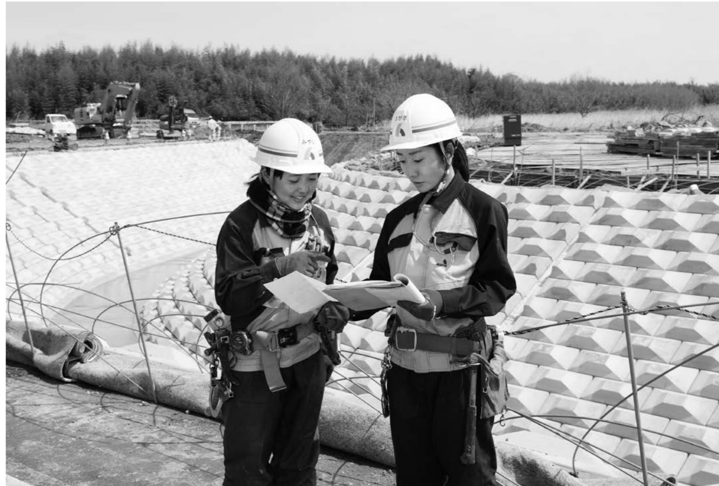
水門の新築工事現場で一緒だった宮地(左)とは、いまま同じ現場で働いている。宮地にとって小笠は姉のような存在だ。
