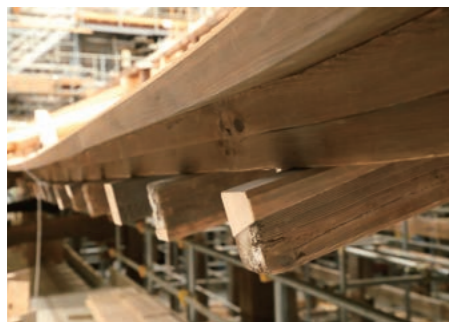
称念寺の修復は精密部品を扱うような丁寧な作業だ。屋根瓦や木製の造作部材には一つずつ設置されていた「番付」を振り、素屋根内で保管する(写真右上、右下)。構造部材も欠損部を新材で補強し最大限活用する(左下)。どうしても再生できない箇所は新材を採用し、平成の仕事であることを焼印で後世に伝える(左上)。
