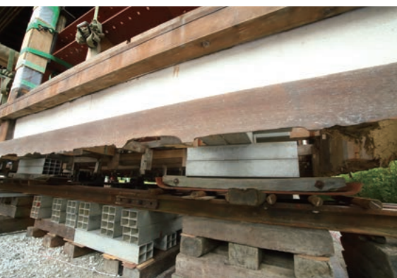
レールの上にスキー板のような「クツ」と細い鋼棒「コロ」を設置して動かす。曳家の原理は古来、変わることはない。
