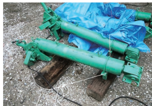
4基の油圧ジャッキが曳家の原動力になる。左側の機構部でレールをがっちり噛むように固定し、それぞれの油圧で調整しながら押す作業を尺取り虫のように繰り返す。
