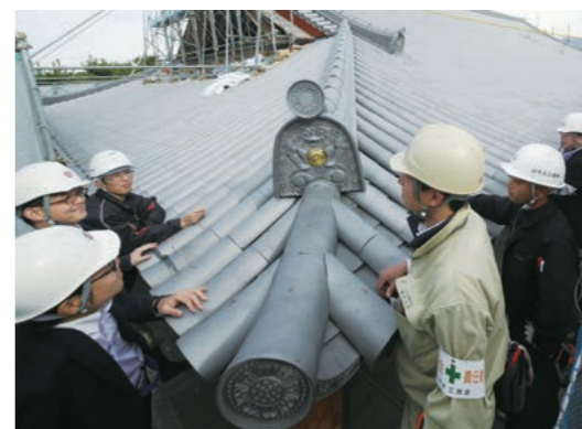
右/鉄骨と木材を融合させることで、古くて新しい古代の建造物を復元する。中/設計者や施工者、大工が一堂に会して施工状況の確認を行う。BIMによって情報を共有しているため話は早い。左/BIMモデルを用いたことで、狭い軒の懐に鉄骨を納め、木造寺院建築の曲面屋根も復元できた。
