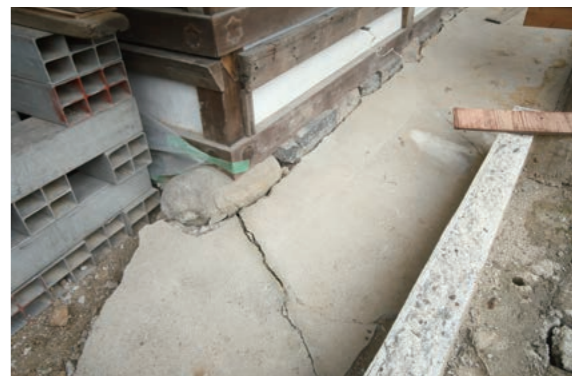
御影堂「殿上及び玄関」の内部にはすでに鋼材が配置され曳家の時を待つ(上)。宸殿より構造が複雑なため難易度は高くなりそうだ。基礎部には不同沈下を示す亀裂が走っていた。進行すれば殿上のダメージは計り知れない(下)。
