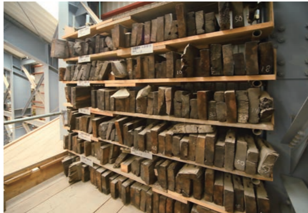
称念寺の修復は精密部品を扱うような丁寧な作業だ。屋根瓦や木製の造作部材には一つずつ設置されていた「番付」を振り、素屋根内で保管する(写真右上、右下)。構造部材も欠損部を新材で補強し最大限活用する(左下)。どうしても再生できない箇所は新材を採用し、平成の仕事であることを焼印で後世に伝える(左上)。
