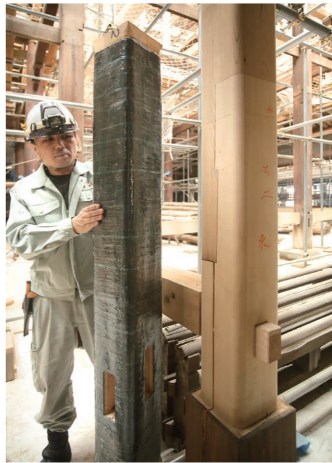
古材と新材の根継ぎ部に炭素繊維を巻いて強化する。豆越主査が見せてくれたサンプルの表面は樹脂を塗布したような仕上がりだが、発想も素材もまったく異なる技術だ。
