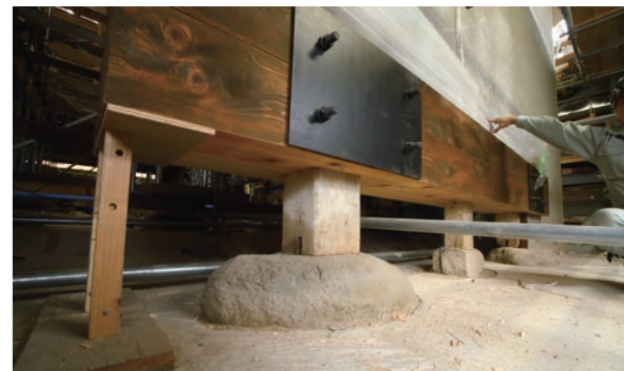
強化されたベタ基礎に礎石がコンクリートで半分埋もれるように固定された。柱には新材で長押補強を施しボルトで締め付けている。
