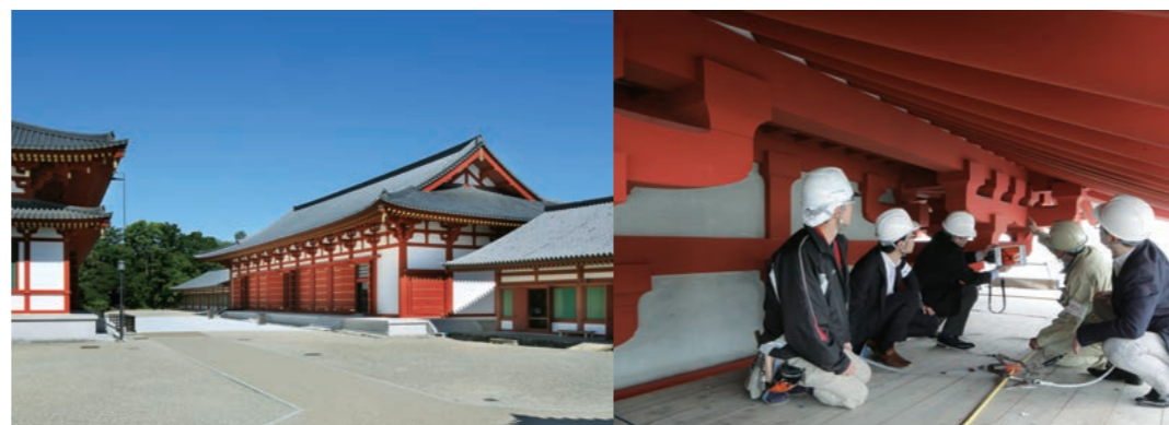
竣工した食堂。復元基本設計と監修は(株)文化財保存計画協会、内部基本設計と監修は(株)伊東豊雄建築設計事務所が担当した。
