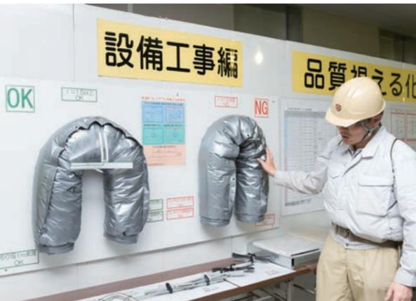
新棟の3階フロアには「見える化」コーナーを設置し、品質を確保するために正しい材料選択がわかるモックアップ、ボードの種類によるビスのピッチの違い、注意事項などを具体的に示している。
