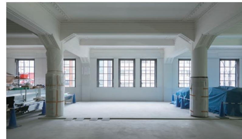
保存棟の5階。改修し、既存の傷んだ仕上げを取り除いたり、浮きを補修し、再塗装を施している。クラシカルな雰囲気を活かしてウェディング施設として生まれ変わる。
