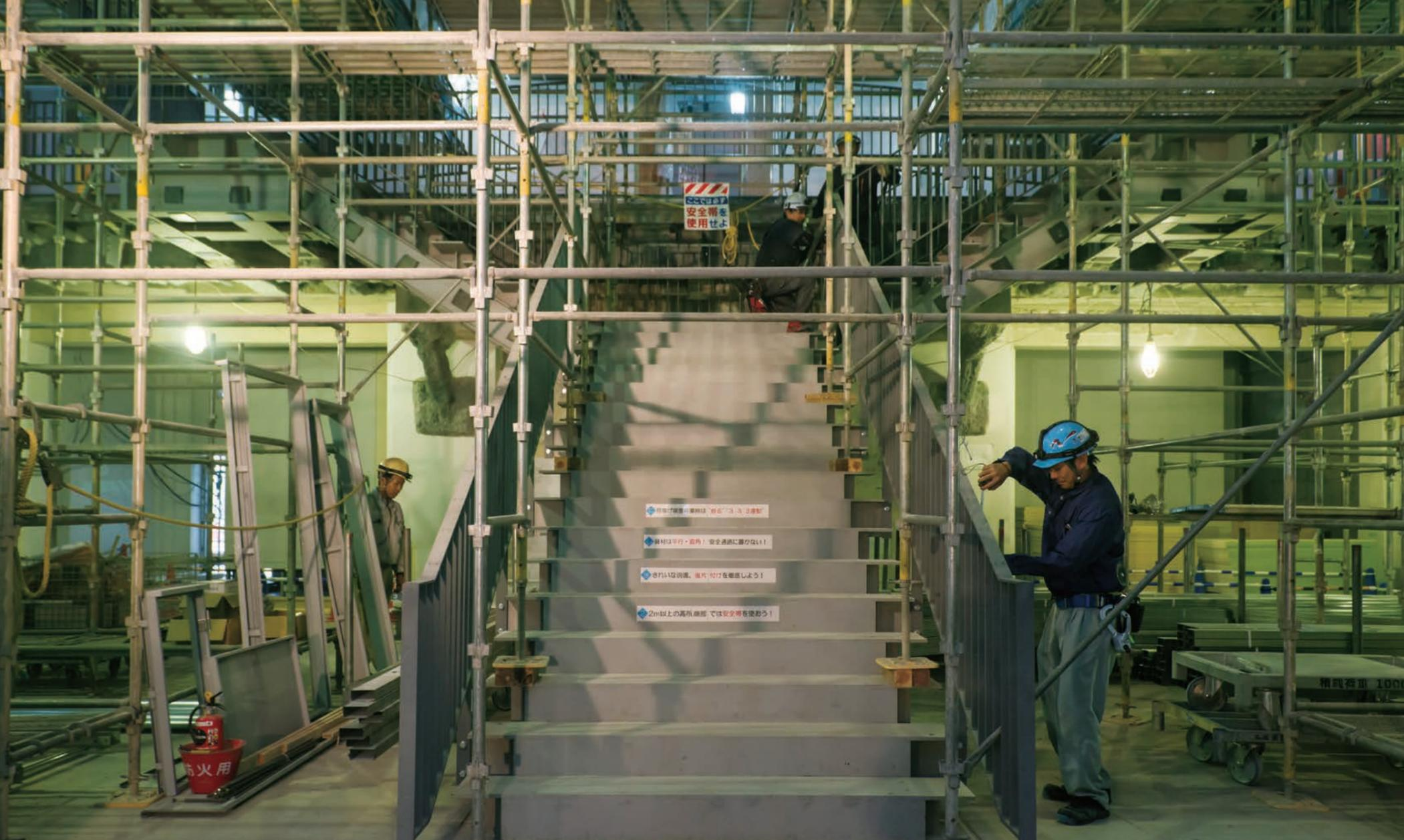
保存棟(旧名古屋銀行本店ビル)の内部改修。当初の改修で塞がれていた吹抜けを復元し、新たに大階段を設けている。耐震補強や壁の増設、エレベーターと階段の設置など、ウェディング施設として活用するためのリニューアルが行われている。
