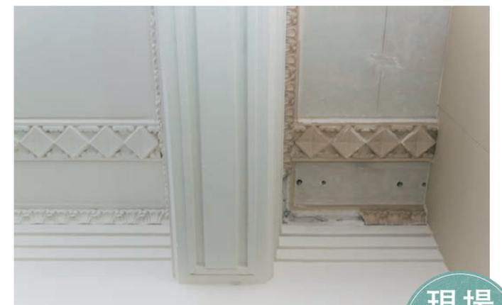
保存棟の各階の天井回りには素朴なデザインのモールディングが施されている。昭和初年の手間をかけた仕事だという。傷んだ仕上げを取り除き、石膏型を取り、ガラス繊維補強石膏で復元。欠損部分も補っている。右は仕上げを剥がした部分。
