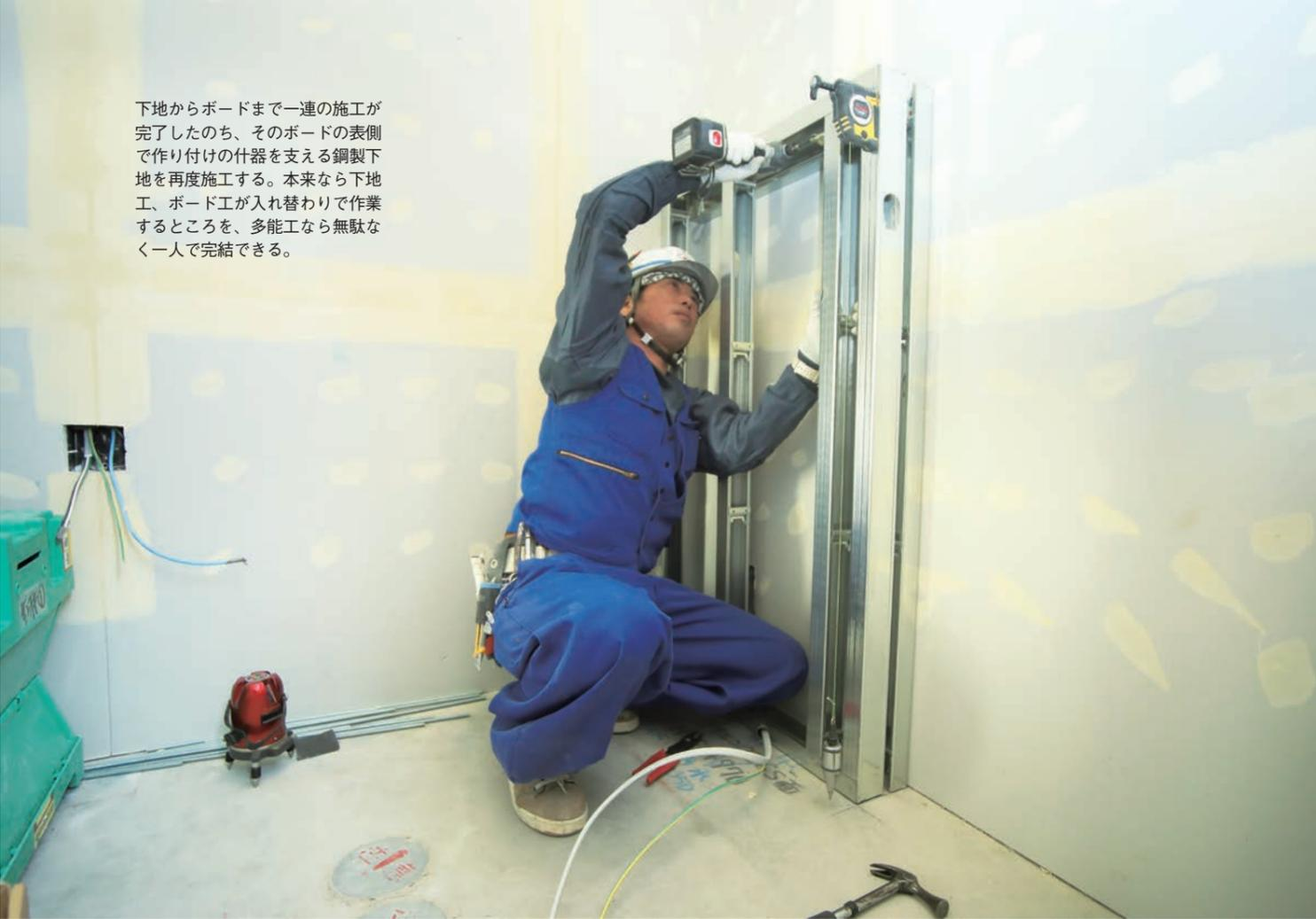
下地からボードまで一連の施工が完了したのち、そのボードの表側で作り付けの仕器を支える鋼製下地を再度施工する。本来なら下地工、ボード工が入れ替わりで作業するところを、多能工なら無駄なく一人で完結できる。
