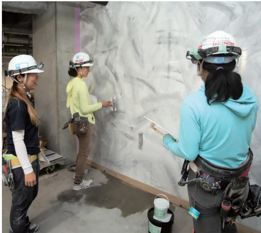
ラウンジ壁面の特殊塗装は技術とともに感性が求められる繊細な作業(左)。1階駐車場の一角に「練習場」を設け、カーブの表現や塗料の濃度を検討しながら特訓した。設計者にもその場に立ち会ってもらい、完成イメージを確認できた。竹延社長は「早めに材料と工程を決めていただけたので、技術に習熟する時間をとることができた」と話す。
