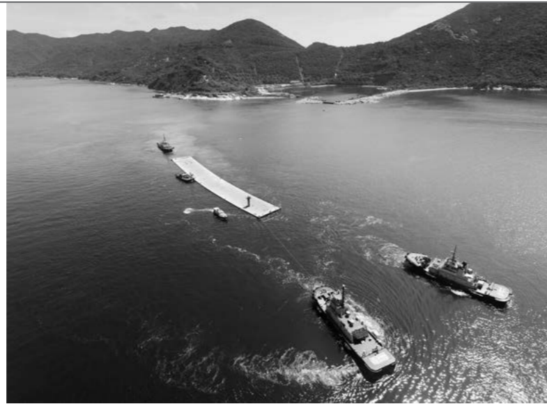
製作ヤード(石澳)から沈埋函を艀装場所に曳航
