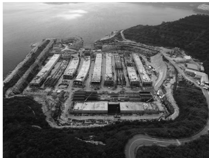
沈埋函の製作(石澳地区)(2016年9月当時)
