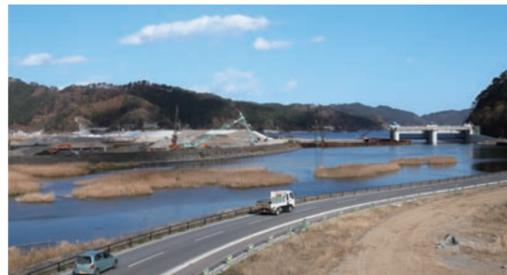
鶴住居復興スタジアムの周辺は土工事が継続中だ。東側の海岸線では防潮堤、水門の整備が進む(右)。北側にはスタジアムと街をつなぐ真新しい橋が完成。斜面には昨春小中学校が開校した(左)。
