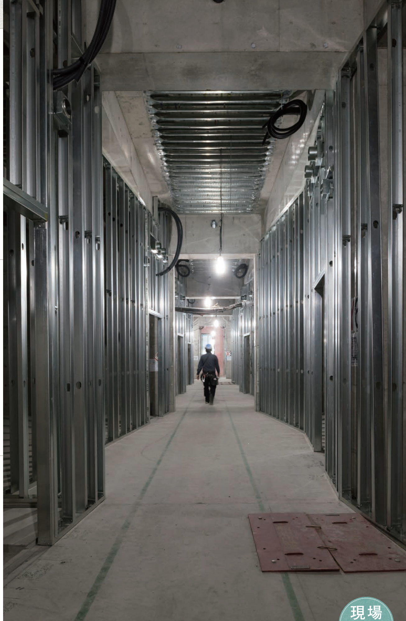
1階のレッスン室が連続する廊下。63室のレッスン室の壁はフラッターエコーを生じさせないように、壁面に7度の角度をつけている。各室の壁下地も真っすぐではなく、ジグザグのラインを描いている。
