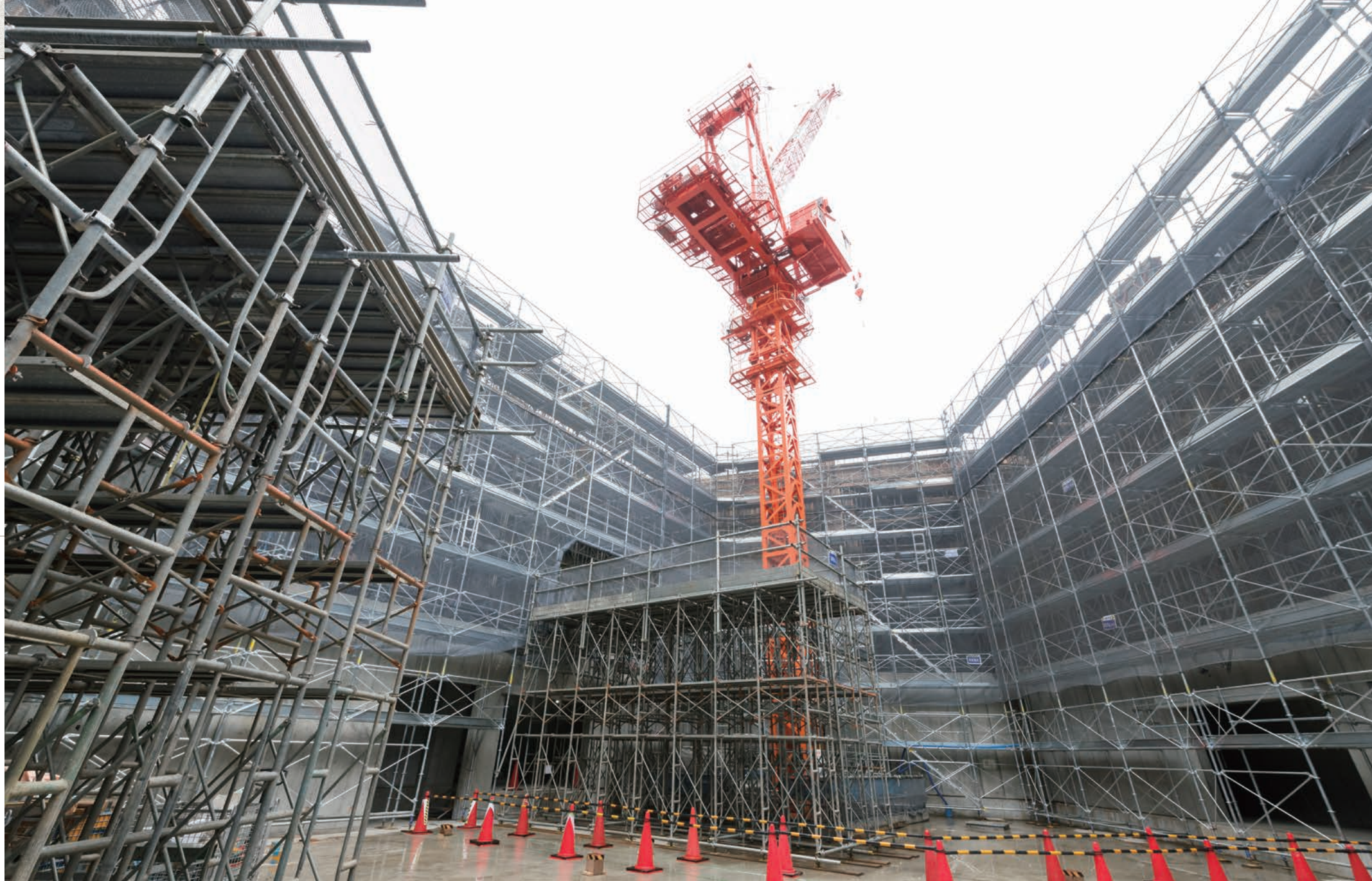
キャンパスの東側に位置する六角形のホールの躯体工事が進行している。舞台から客席の背後まで長手方向に約35m。客席数は422席。写真は舞台側を見ているが、両サイドの壁面の角度が開いている。2階から4階までの3層吹抜けで、これから屋根が架けられていく。
