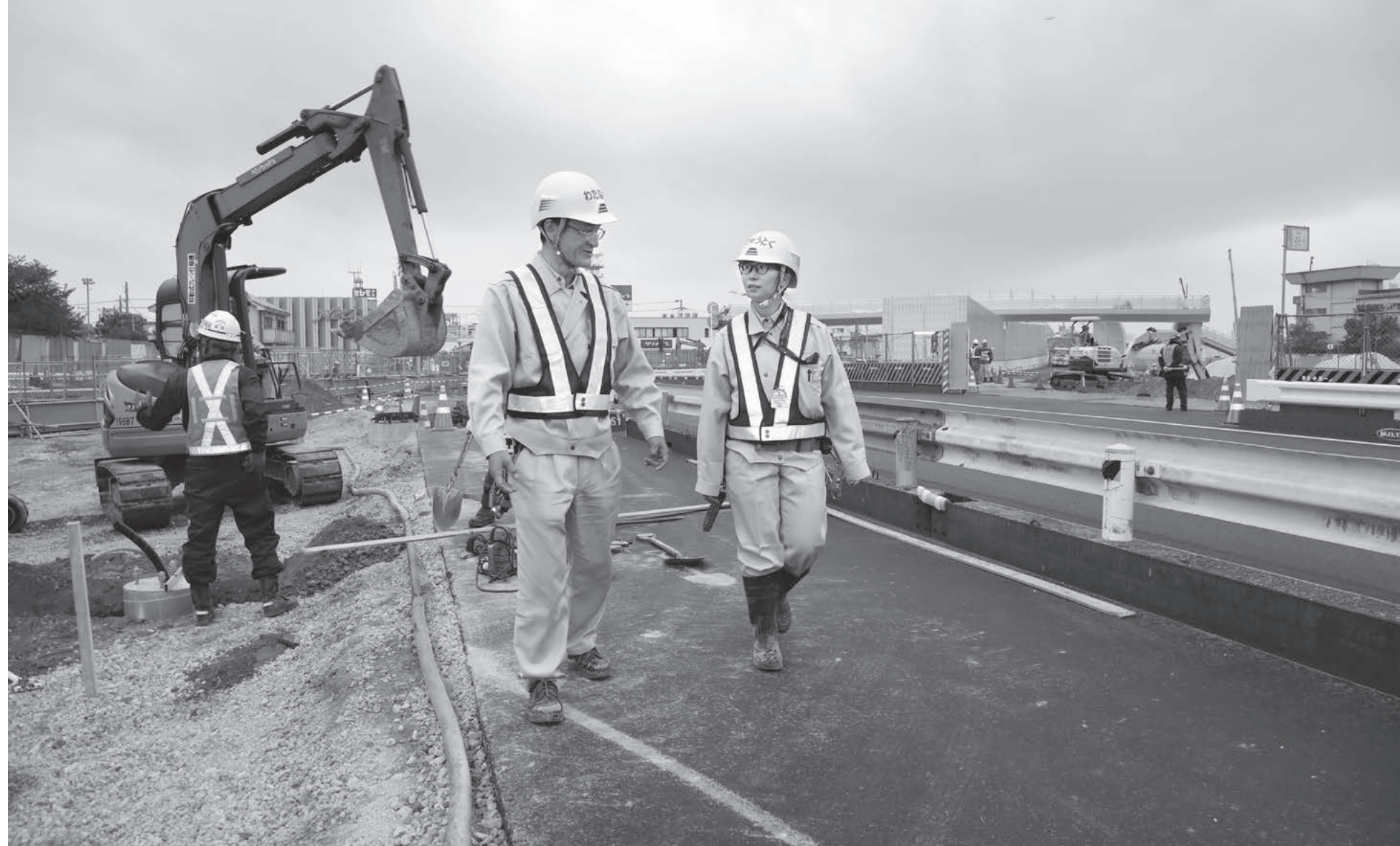
4ブロックに渡る現場は極めて広大。大きな道路をまたぐように現場が広がっている。
