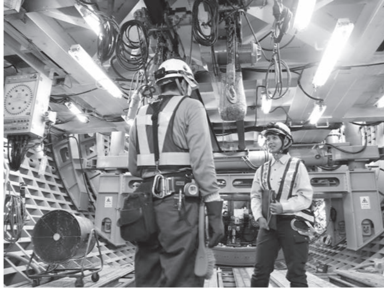
現場は地下40m。日々のコミュニケーションを大切にしている。
