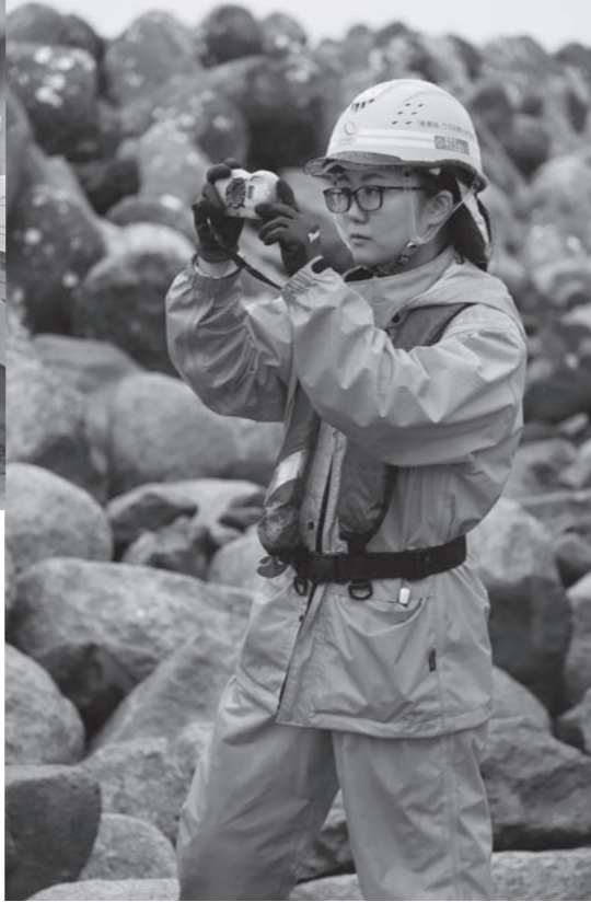
上／「写真を撮りましょう！」という鈴木への掛け声で、オフィスの反対側からも駆け足で人が集まりたちまち皆笑顔に。前列左端が諸橋作業所長。右／消波ブロックを移設する際は、一つひとつの重さ、破損の有無を確認して記録する。
