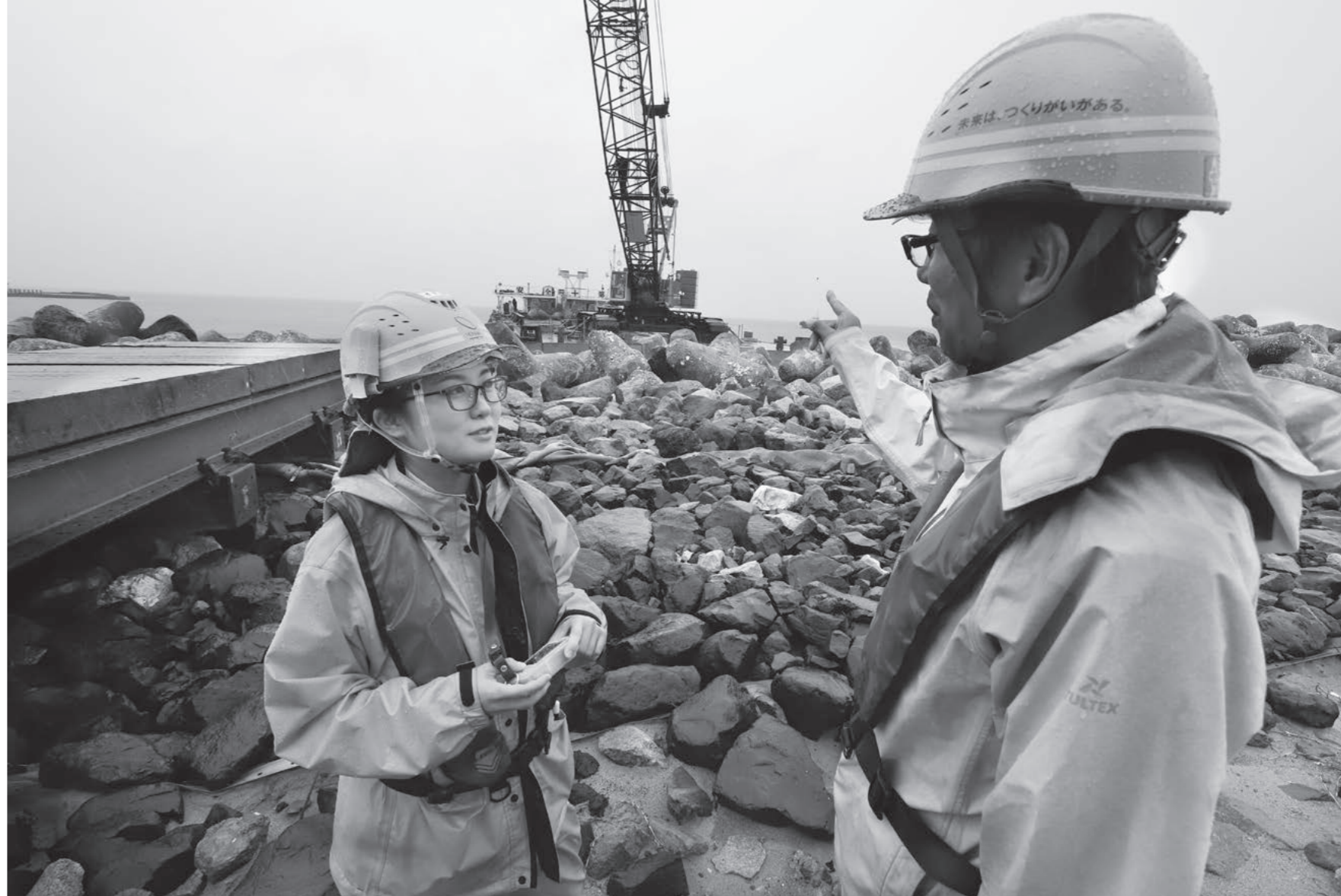
取材当日の天候は、あいにくの雨。海岸に積んである消波ブロックの移設工事を鈴木は念入りに記録し、スタッフと状況を確認し合う。
