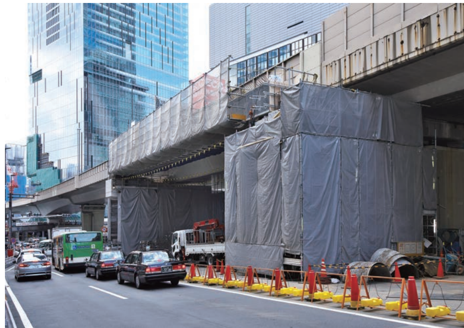
上／約半世紀前に造られた薄型の橋脚を抱くように新たな柱を建てて、既設橋脚と一体化する。 左／新たに桁を架けるための橋脚を施工する。
