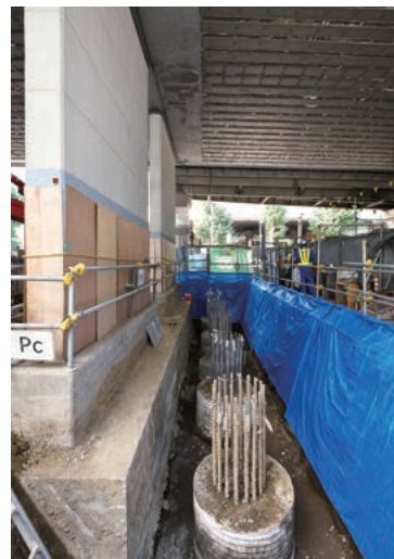
上／約半世紀前に造られた薄型の橋脚を抱くように新たな柱を建てて、既設橋脚と一体化する。 左／新たに桁を架けるための橋脚を施工する。
