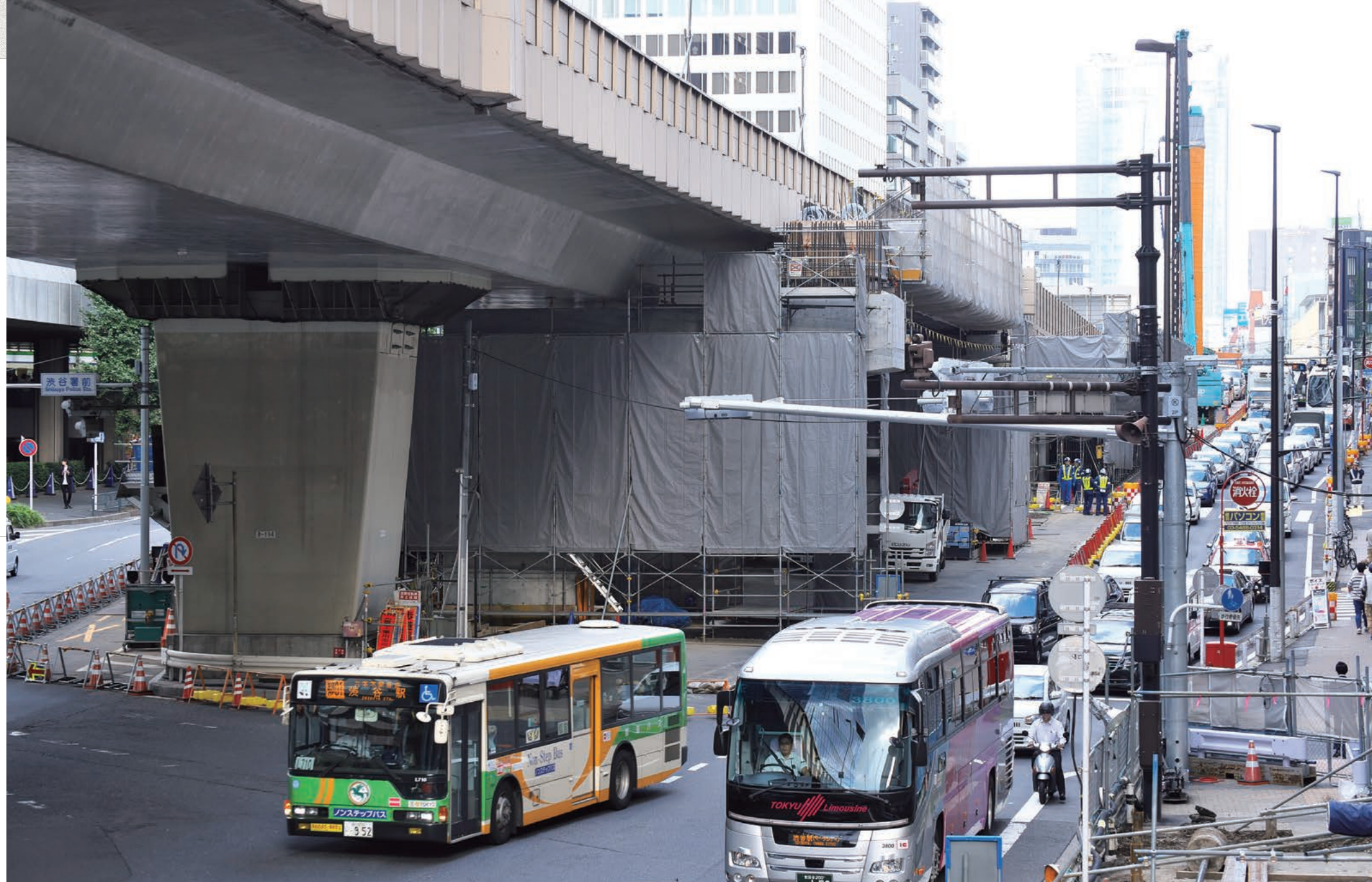
渋谷警察署前の交差点。画面奥の六本木方面から首都高速3号渋谷線の下りに合流する入口を構築する。
