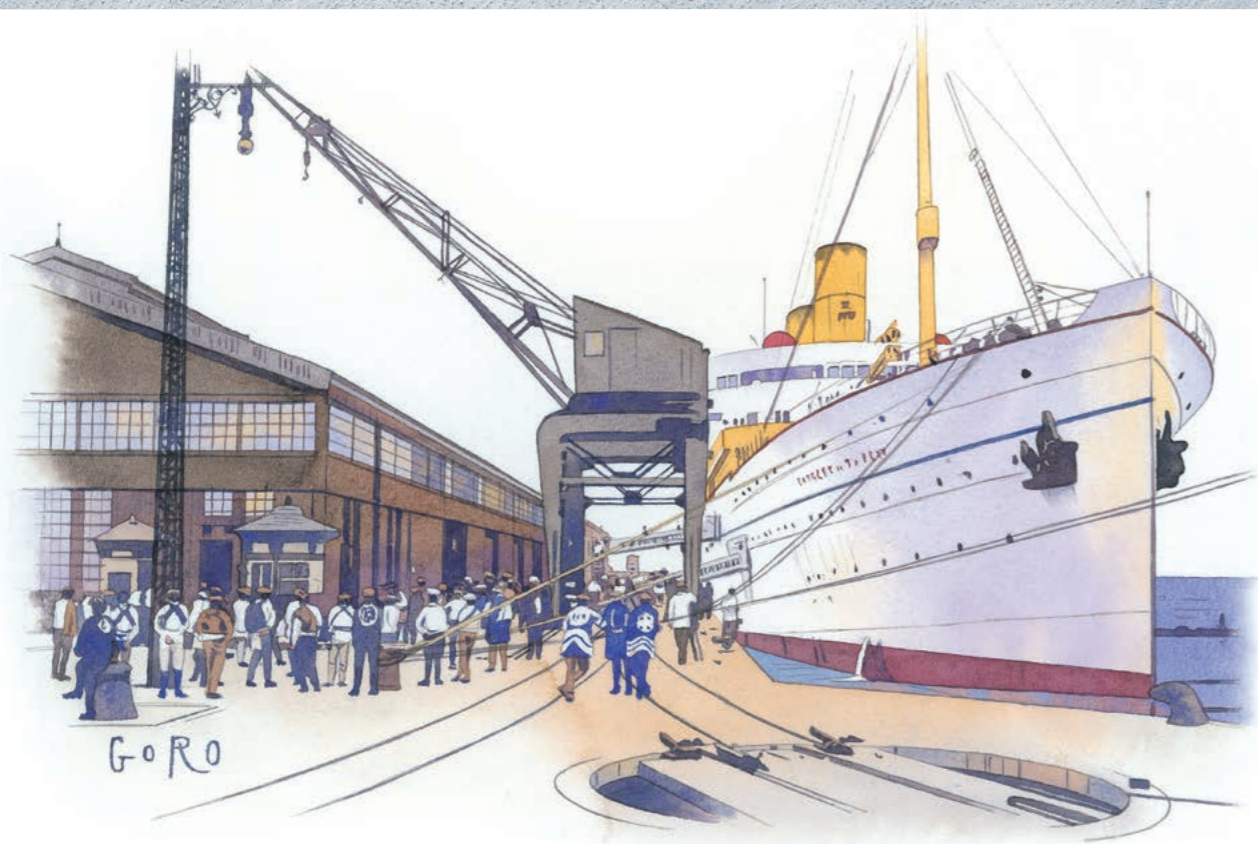
大正期、横浜港新港ふ頭完成後の情景。日本初となる係船岸壁の周囲には税関の建物と荷役用のクレーンが配備され、施設間を貨物車用のレール網が結んだ。完成した港には貨物船や海外客船が寄港し、国際港としての賑わいを見せた。
