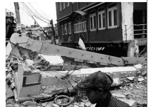
倒壊したホテル (カトマンズ)
