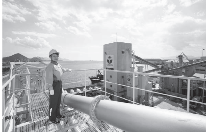
調達業務は実際に現場を訪れることも非常に大切だ。写真は取引先の生コンプラントにて。工場視察のひとつコマ。(写真提供：三井住友建設(株))
