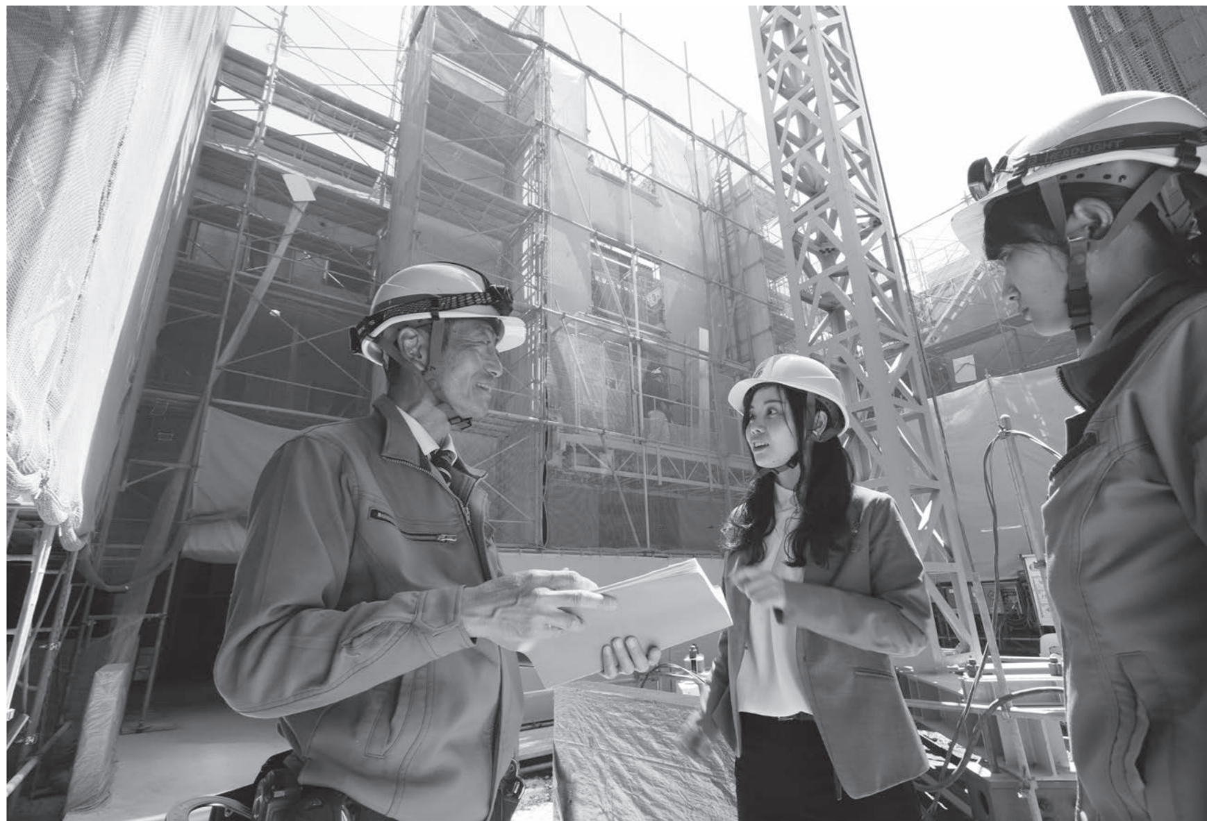
自身が設計を担当した施工中の現場で、岩戸昌浩所長と。細かな事項でも直接話して確認を行う。
