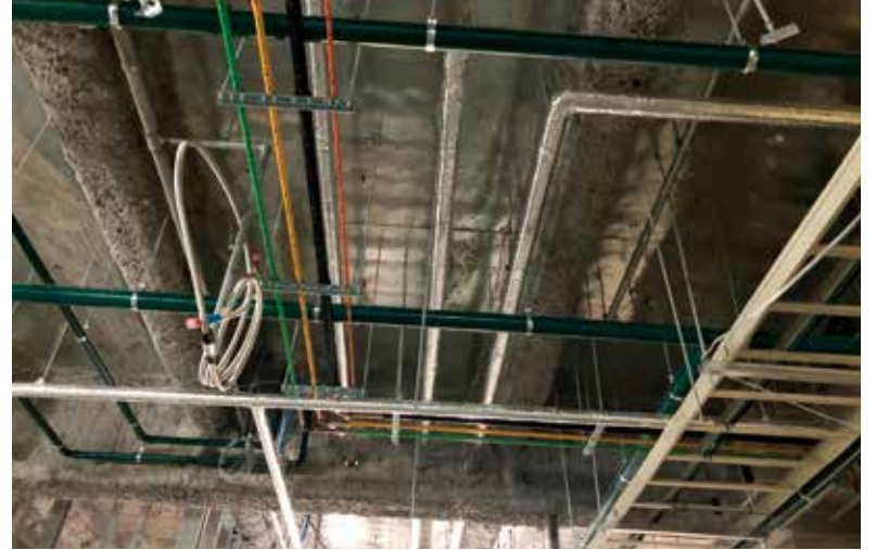
医療用ガスの配管作業はボルトや他の配管との離隔が詳細に規定されている。電気配管などとの干渉を検証しながら施工する繊細な作業だ
