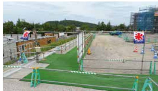
施工用のメイン通路には人工芝やミストシャワーを設置し安全性の向上を図っている
