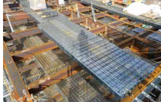
工場で作成された配筋付デッキを現場に搬入し、施工するなど、様々なユニット工法により生産性が向上した
