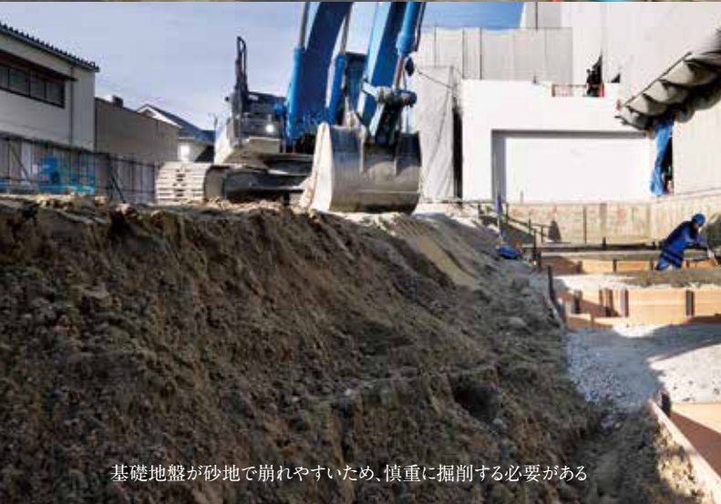
掘削工事・鋼製型枠設置中（提供：佐藤工業株）
