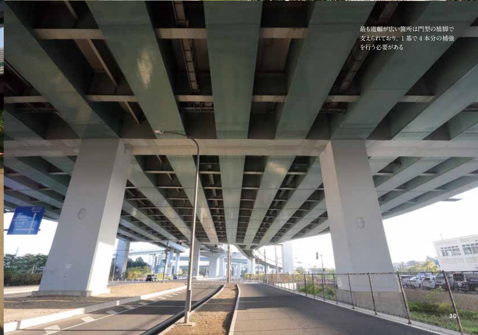
実際の橋脚・橋桁の状況(左)と、3Dレーザースキャナーで測量したデータ(右)の比較。極めて正確なため、右側の仮想空間内でも再計測が可能(右画像の提供: ㈱竹中土木) ※3D測量データは、RC橋脚の耐震補強(炭素繊維巻立て工)実施前なので、枠内に相違があります。
