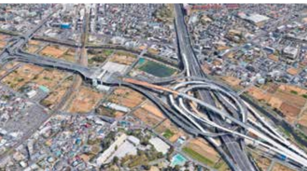
上空から見た横浜青葉 IC 付近 (提供: (株)竹中土木)
