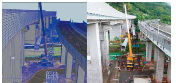
現況、設計、施工機械のデータを仮想空間上に再現した施工シミュレーション(左)と実際の施工の様子(右)(提供:清水建設株)
