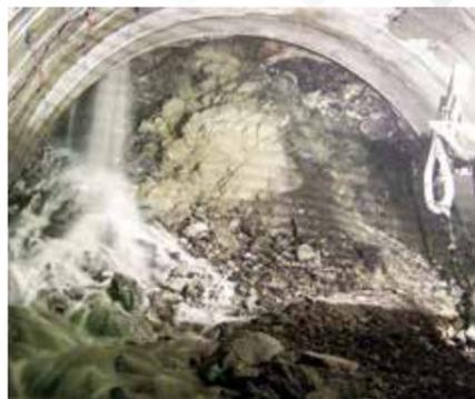
トンネル掘削時の切羽からの大量湧水状況
