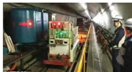
セグメントをシールドマシンの先端まで運ぶ台車を動かして実況
