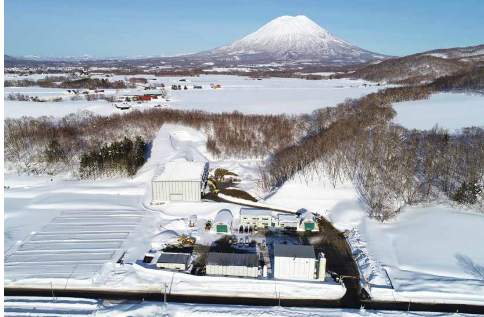
冬季の積雪時の現場。多機能防音ハウスはもちろん、受電設備や濁水処理設備なども手前の建屋内にあるため、雪の影響は受けにくい。(提供：飛鳥建設株)
