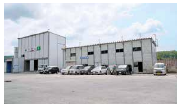
防音ハウスと同じように、他の施設も雪の影響を受けないよう建屋で覆われている。写真左はスマートパッチャープラント、右は濁水処理設備。
