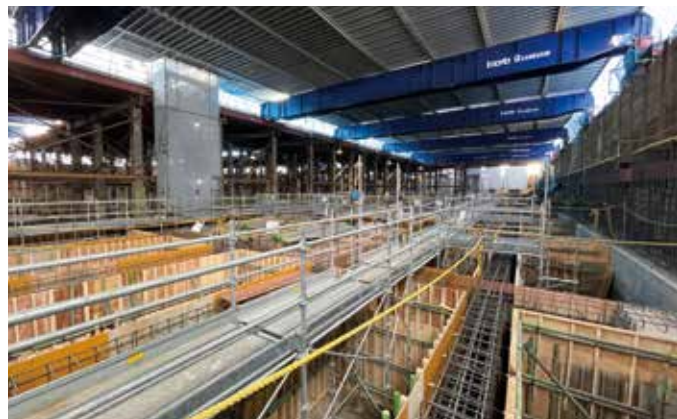
プレガーダー部材が支える作業空間の様子。中間支柱のない大空間で降雪の影響を受けず快適に作業を進めることができる。(画像提供：大成建設㈱)
