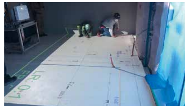
設備工事に用いられたプロジェクターによる墨出し情報の投影。墨出し工の労務問題解決の一助となった。(画像提供：大成建設株)
