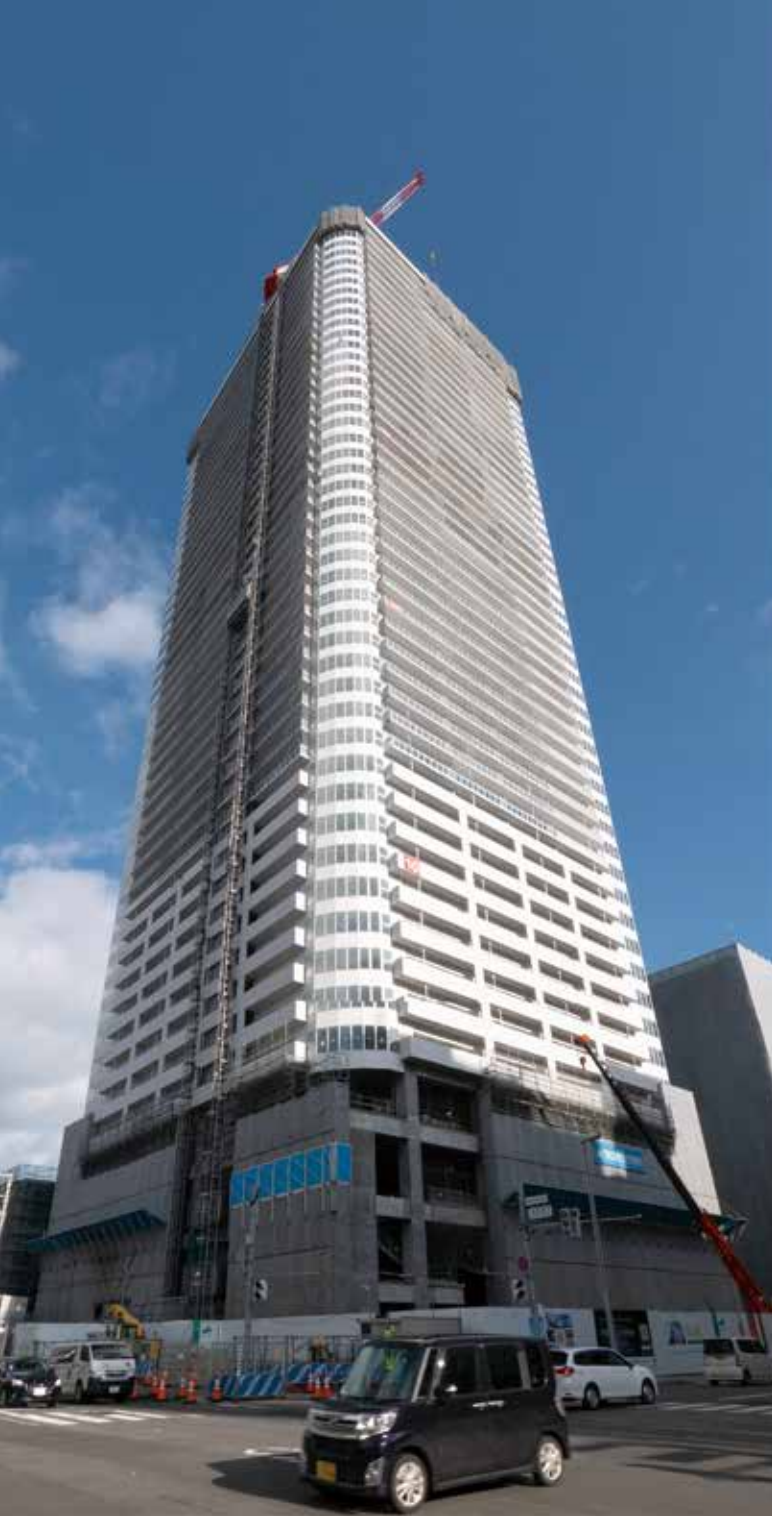
住宅棟の外観。道内最高となる地上175mの躯体はほぼ完成している。
