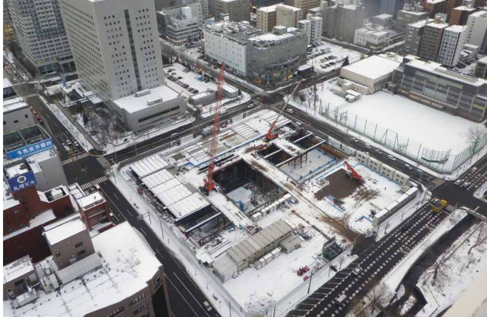
地下躯体工事の際に設置した冬期養生用の上屋。『プレガーダー部材』によって、支保工なしで22mのスパンを覆っている。(画像提供：大成建設㈱)
