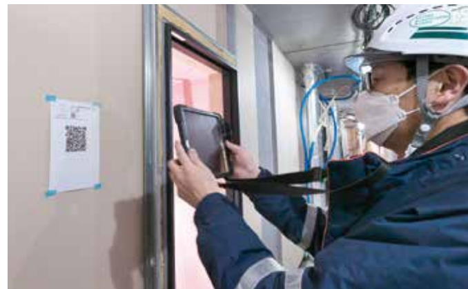
市販の進捗管理用アプリなどを使用し、各個室の横に掲示した二次元コードをタブレットで読み込み、入力することで、最新の進捗状況を共有できる。
