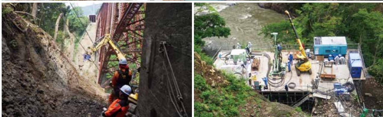
上／旧橋と同様の構造で復旧した第一白川橋梁。今年中に予定されている立野ダム試験湛水の際には半分ほどが水面下に沈む。その風景も楽しみだと津留専務は話す。下／施工中の様子。左がセーフティークライマー工法、右が高耐力マイクロパイル工法（いずれも提供：株福田組）
