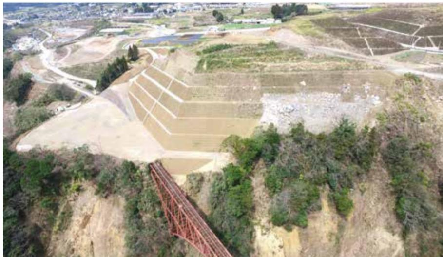
第一白川橋梁につながる犀角山トンネルは山を掘削して撤去された。(提供：㈱福田組)
