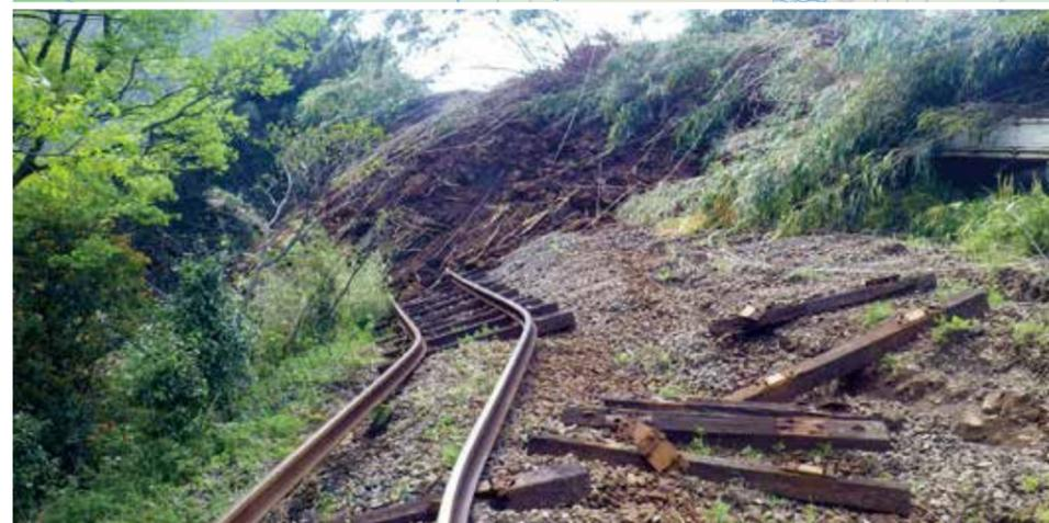
立野駅から高森駅まで17.7kmをつなぐ南阿蘇鉄道。熊本地震により立野駅～中松駅間では橋梁、トンネルの損傷、盛土や軌道の変状、落石や護岸の崩壊など40カ所以上で被害が確認された。(下写真提供：南阿蘇鉄道株)
