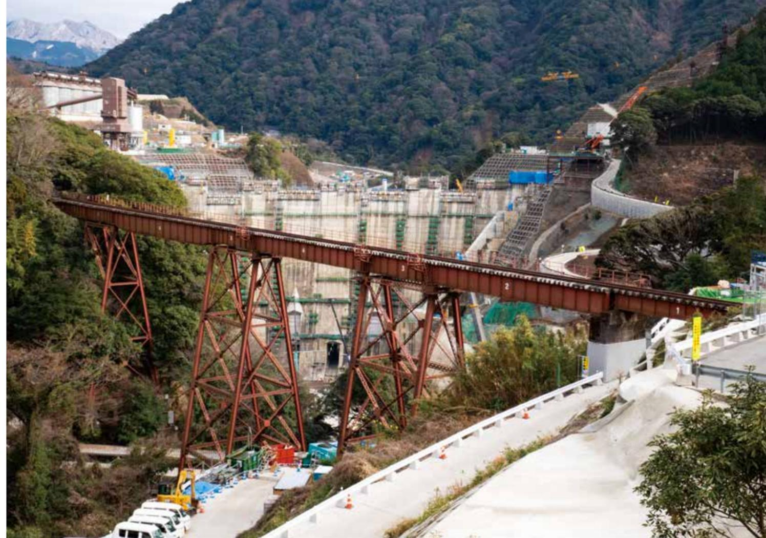
立野駅に近い立野橋梁は橋脚が大きく損傷したため鋼材を巻き立てて補強された。この橋梁と犀角山の斜面は立野ダムの建設現場と輻輳していたため厳密な施工計画、工程管理が求められた。
