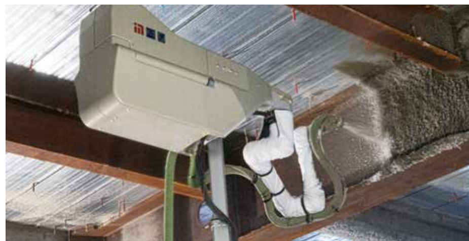
左・上／鉄骨に耐火被覆を吹き付けるロボット。センサーで鉄骨の形状を取得し、自動で吹付作業を行う。
