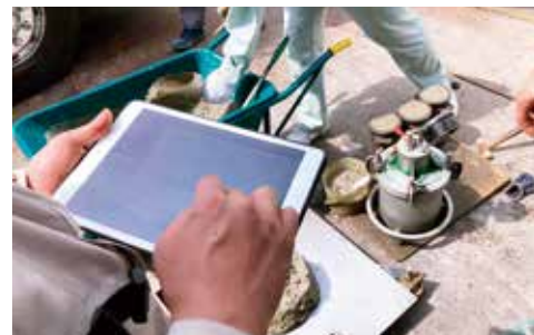
生コン車の運行状況、平均的な運搬時間、打ち重ねの際の時間間隔などの情報をタブレット上でリアルタイムに把握・共有できる「生コン打設管理システム」(画像提供: 鹿島建設株)
