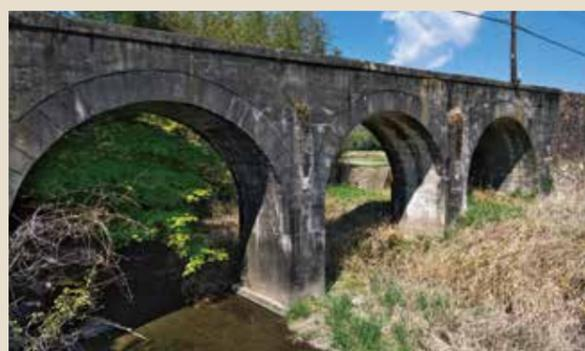
六把野井水拱橋から東へ200mほど離れたところでは明智川拱橋が三岐鉄道北勢線の軌条を支えている。この3連式アーチ橋もコンクリートブロック造。田園風景に黄色い車両が映える鉄道ファンの人気スポットだ。このめがね橋も2009年、ねじり橋と共に土木学会の選奨土木遺産に認定されている。
