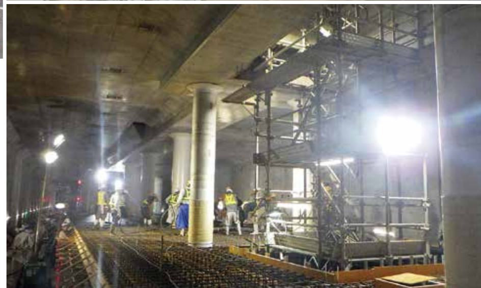
上／地上の狭い開口部から軌道工事の資機材を搬入する。 下／ホームのコンクリート打設の様子
