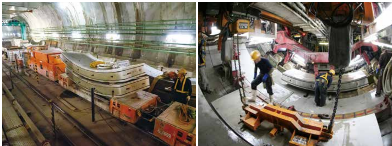
上／SENSからシールドへの換装地点。左の写真手前がSENS、奥がセグメントで構築されている。右は換装地点での覆工作業の様子（写真提供：大成建設株） 下／セグメント区間の施工の様子。搬入されたセグメントは切羽に運ばれ順次組み立てられていく。（左写真提供：(独)鉄道建設・運輸施設整備支援機構、右写真提供：大成建設株）
