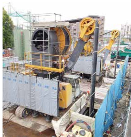
低空頭の掘削機で周辺への圧迫感を低減した。
