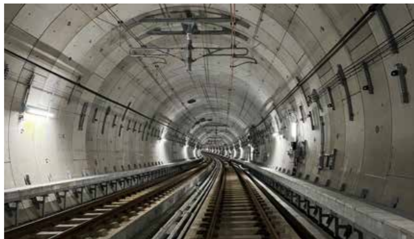
完成したトンネル坑内（写真提供：大成建設株）
