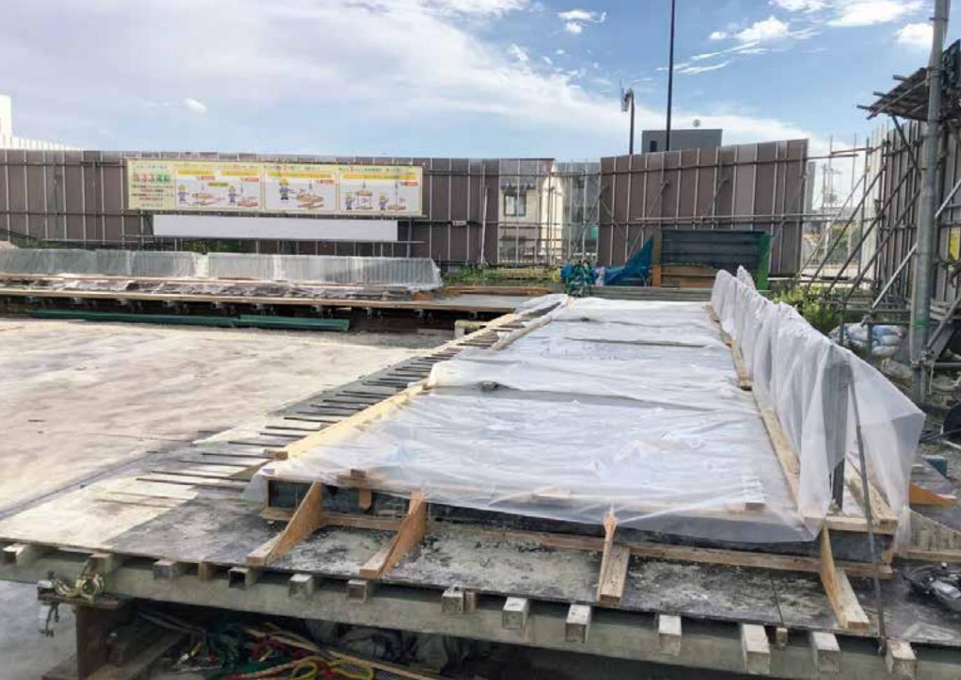
上/ヤード内でのPC地下外壁の製作状況。建物の外周にゆとりがあったことから、既成杭の打設と並行して行うことができた。右/PC地下外壁の建て込み状況。部材の図面と現地での施工管理は入社2年目の後藤さんが担当した。(それぞれ画像提供: ㈱竹中工務店)
