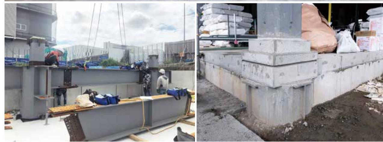
上・左下/CPC施工の様子。基礎躯体に鉄筋・型枠は一切使用しない。(画像提供: ㈱竹中工務店) 右下/地上部にごくわずかに見えているCPC
