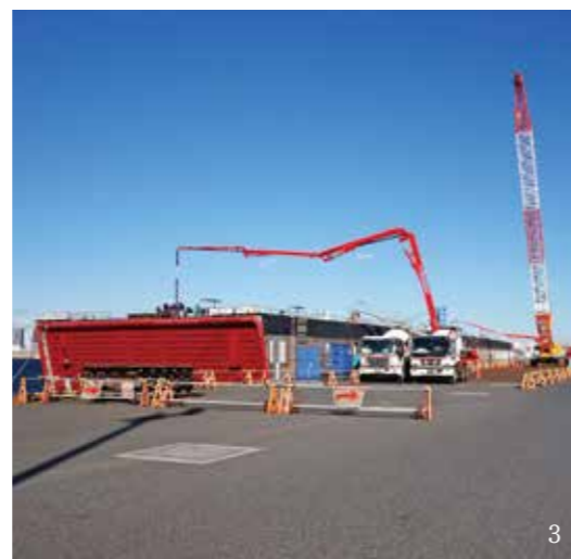
1. 海の森トンネルおよび本工事施工範囲 2. 6号函鋼殻製作 3. 6号函コンクリート浮遊打設
