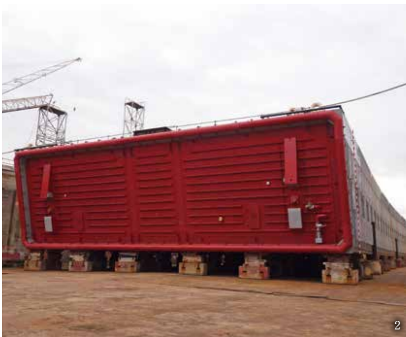
1. 海の森トンネルおよび本工事施工範囲 2. 6号函鋼殻製作 3. 6号函コンクリート浮遊打設
