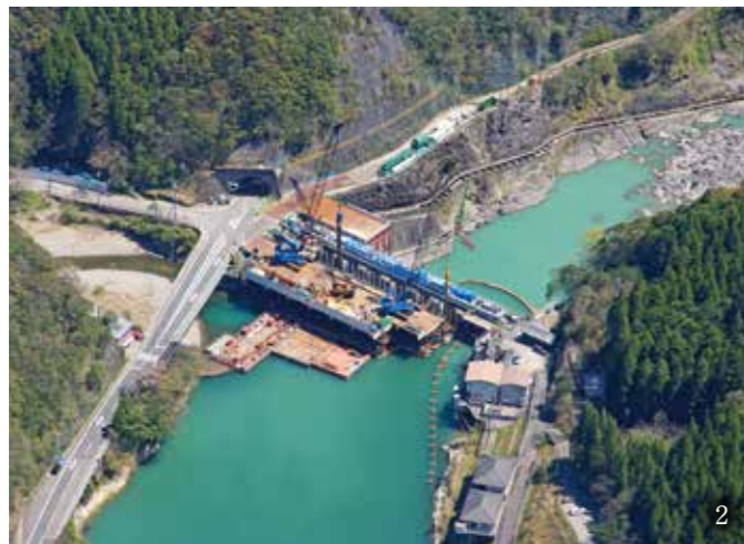
1. 改造前既設堤体 2. 仮締切設置状況 3. 堤体改造全景
