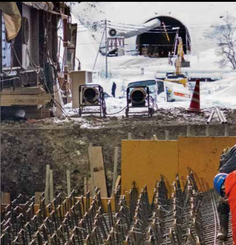
貫通した豊野トンネル内から幌内トンネルをのぞむ。
