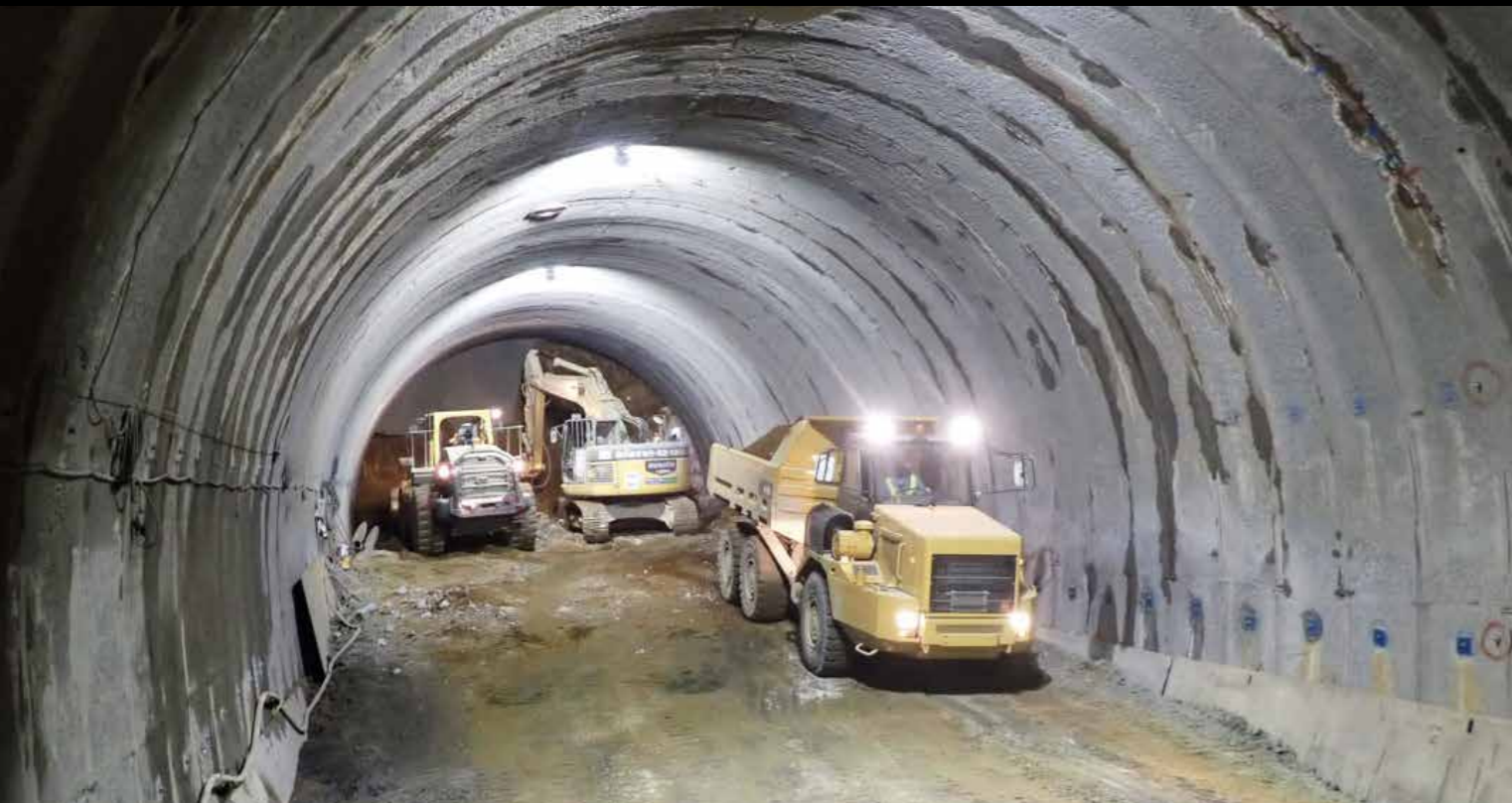
幌内トンネルではインパートの取付けと吹付けが行われている。貫通まではあと160m(1月取材時点)。貫通は3月中旬を予定。(提供:青木あすなる建設株)
