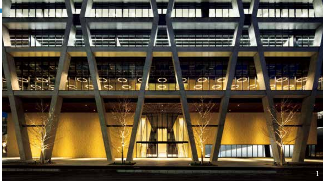
1. エントランスホールのシアリンク型ブレース 2. 3階ピロティ 3. 5階学生交流スペース
