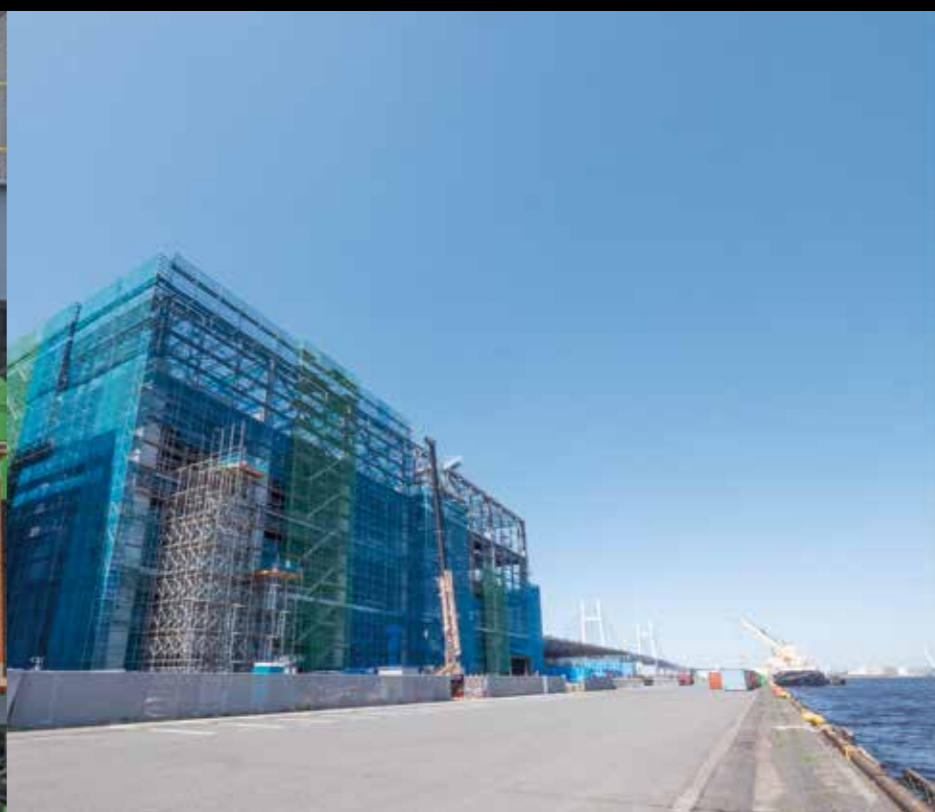
海側から見た現場。過去に幾度も埋め立てが行われたため、旧護岸が敷地内に存在している。施工前にボーリング調査を行い、地中に杭を打ち込み、地盤への対応してから施工が開始された。
