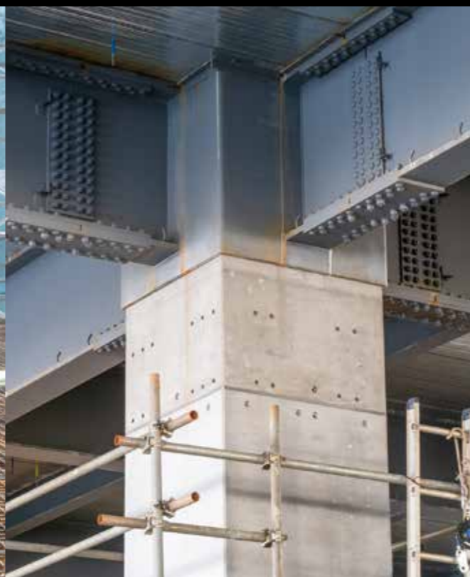
ハイブリッド構造の梁と柱。コンクリート強度は上柱が60N（ニュートン）、下柱が48N。コンクリートの配合量の差は、表面の違いからも見てとれる。
