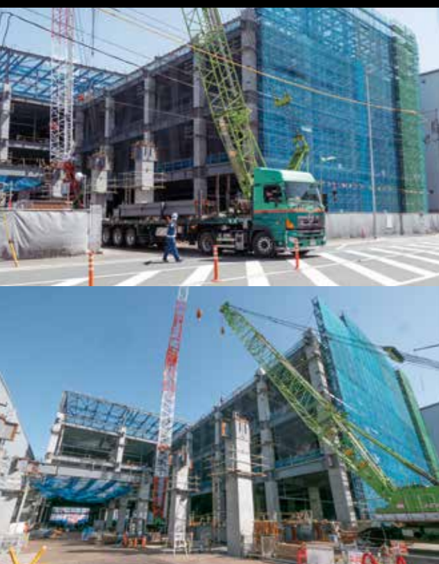
BIMで作成した3Dモデルを活用し、円滑な資材搬入とクレーンの作業エリアの確保を可能にした。
