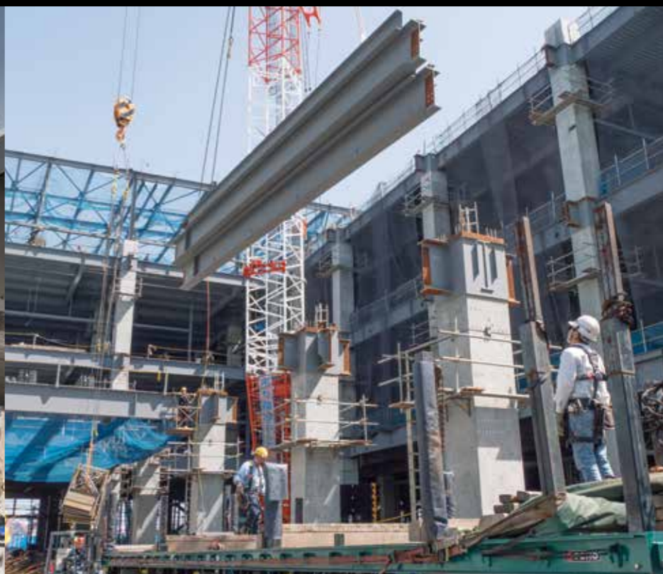
梁の搬入状況。梁は中国の工場で作られたものを使用している。中国ではすべての部品を組み立ててつくるので、ミリ単位で調節ができ、コスト管理もしやすいという。
