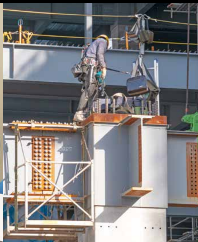
柱と梁の接続作業の様子。
