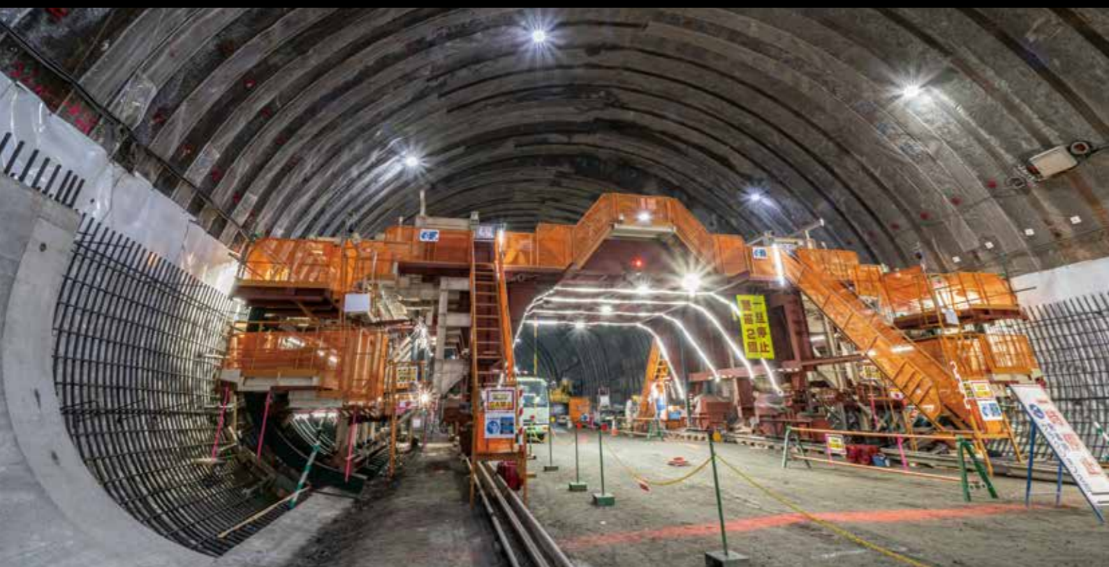
2分割されることが多いトンネル支保工だが、今回は4分割したものを組み立てて補強した。側面の立ち上がり部分は側壁コンクリート工で固めている。
