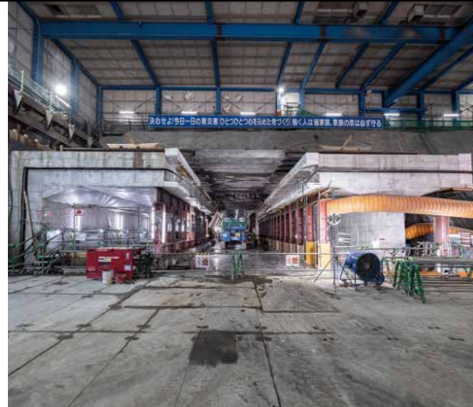
白い躯体がそれぞれカルバートのL型パーツ(左)とT型パーツ(右)。これから両者の上部間に鉄筋を組んでつなげる工事に着手する予定だ。
