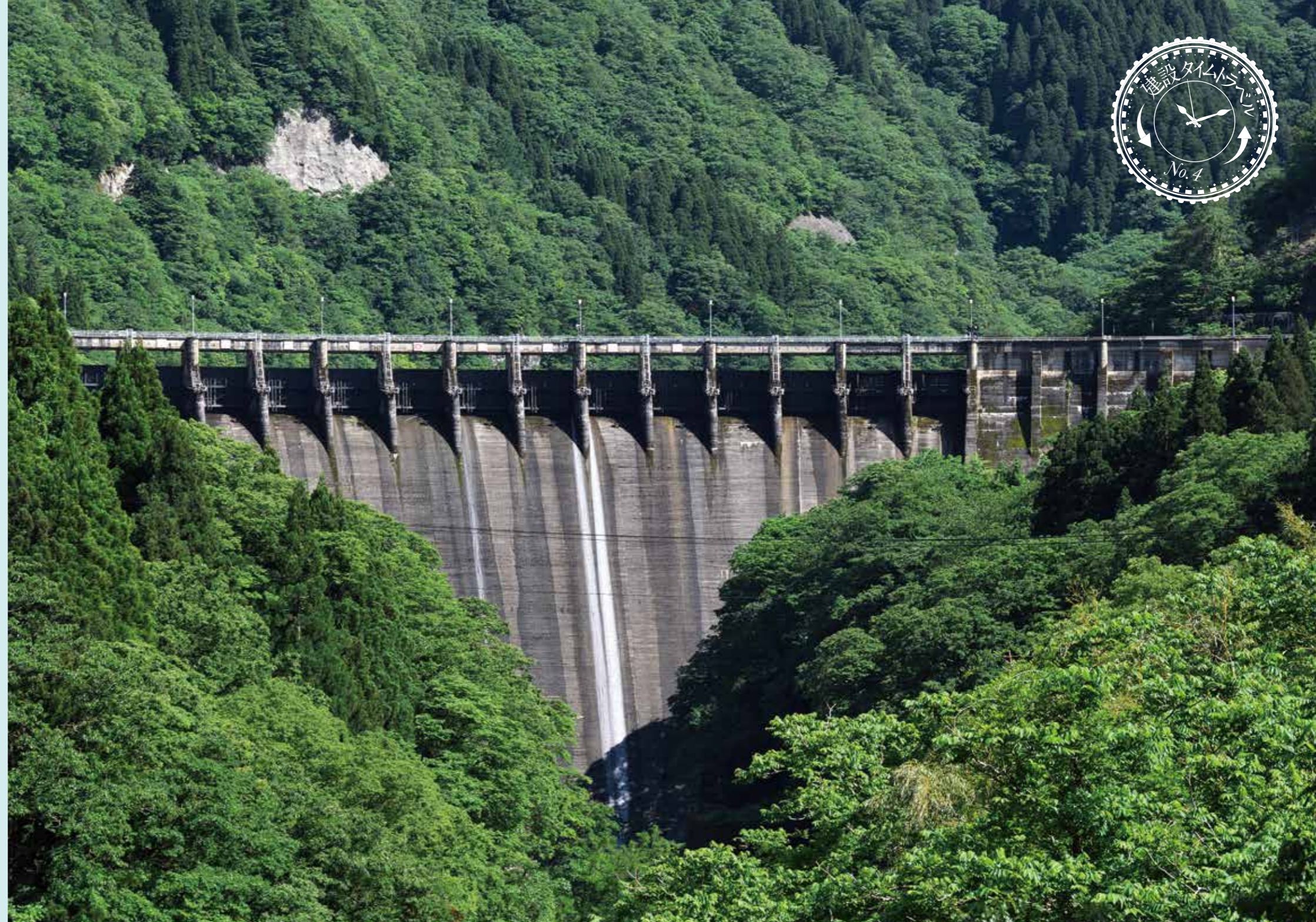
監査廊は堤体の上部と下部にある。下部の監査廊には左手の階段から下りる。
