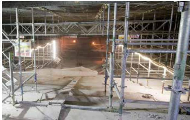
傾斜のあるシアター形式の講堂は鋼製の梁を渡してフラットにする。既存躯体が複雑に交差する狭隘な現場の施工には、BIMを導入して工程を子細に検討した(左画像提供:橋本店)。
