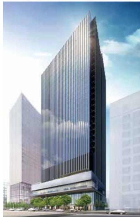
TODAビルは1階床下に免震層、上部構造には独自の連層耐震壁(コアウォール)を配置した免震構造。広場は災害時に避難者の一時滞留エリアとして開放され「芸術文化の拠点」でありながら「地域の防災力強化」も約束する。ZEB Readyの認証取得をはじめ最高レベルの環境性能と耐震性能を誇る同社が有する技術の集大成といえる建築物だ。
