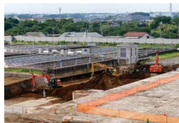
本工事で設置した防音壁の先には、民家が並ぶ
