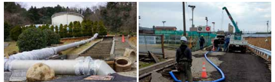
七尾市 【水道】仮設配水管による応急対応
