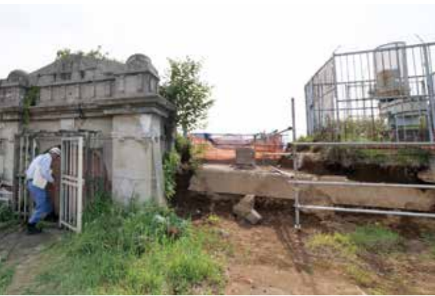
左/既に稼働を休止している1号配水池の東側通路入り口となる坑門にはドイツ風の意匠が凝らされている 右/土木遺産として東西に2つある坑門のうち、西側のひとつが場内南東部に移設・保存された。配水池内部には、かつて満々と命の水を蓄えていた大正期の建造物の荘厳さが伝わってくる
