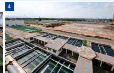
左/水源から自然流下で導水される相模湖の水がこんこんと湧出する着水井。この水を止めることはできない。新たな屋根付きの着水井を整備し切替えた後にこの施設は撤去される 右/中央に見える供用を終えた1号配水池を撤去し、ろ過池を新設する。撤去には約1万㎡のコンクリート廃材が発生すると予想される。周辺地域への更にも細かい配慮が求められる
