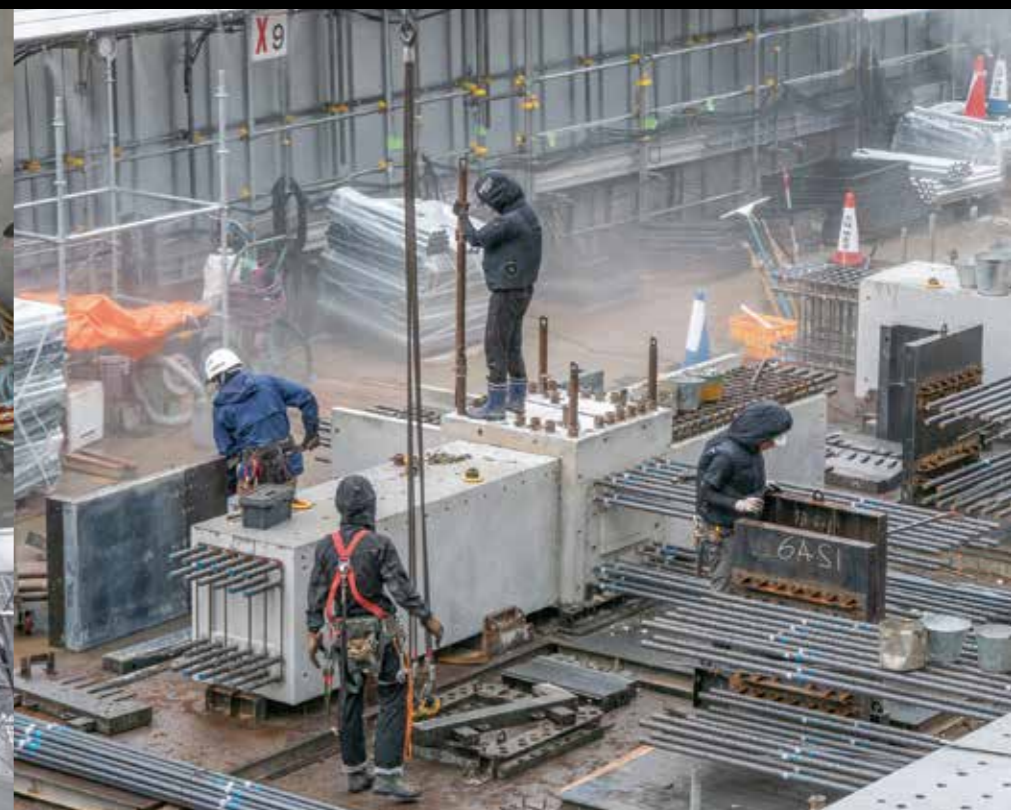
PC梁は仕口部分のみサイトPCとして製造し、設置階に揚重される
