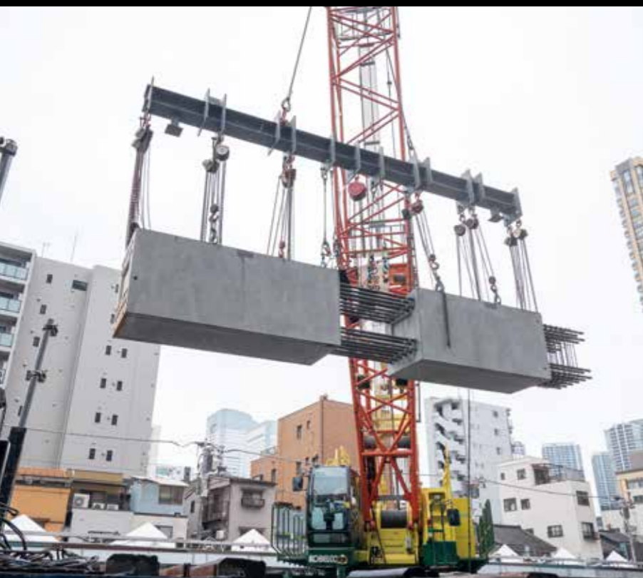
サイトPCヤードへのPC搬入状況
