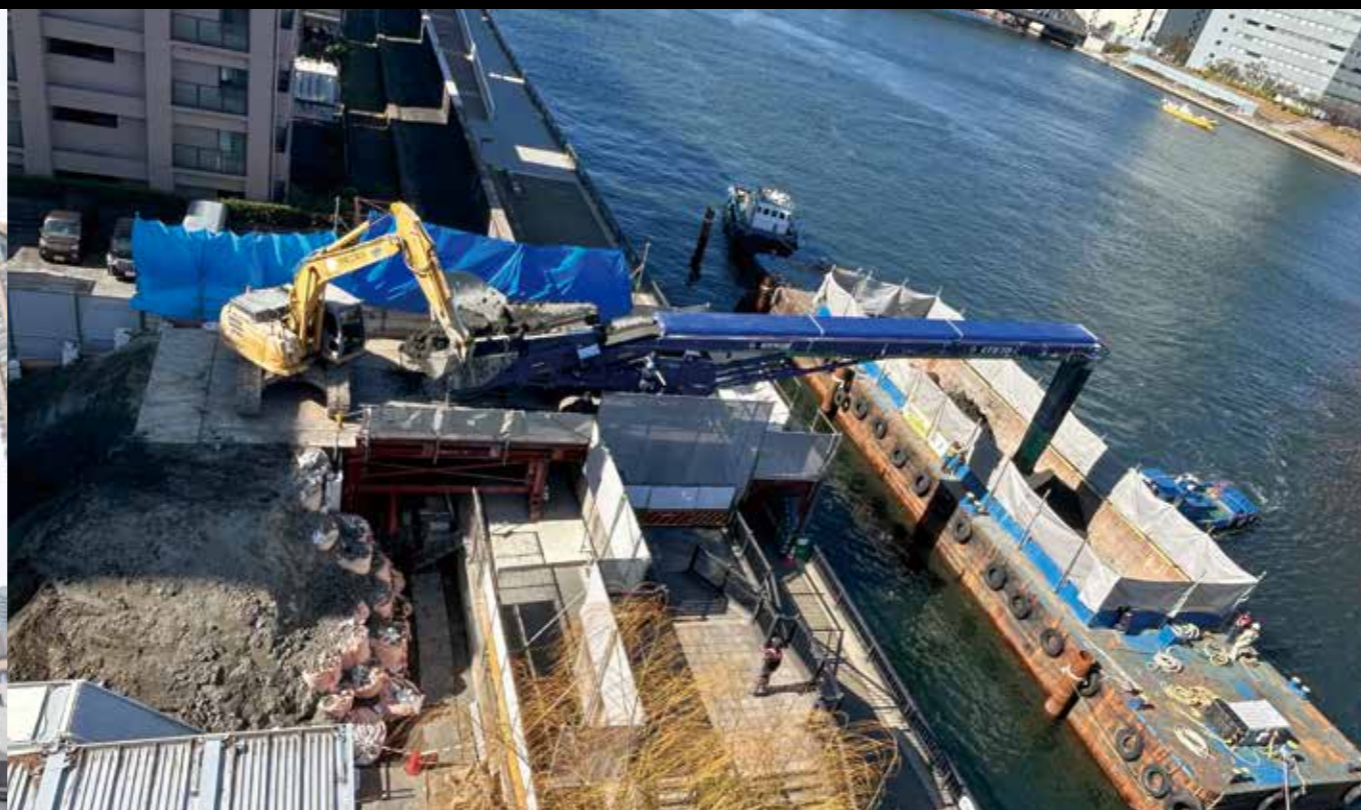
B-1街区で行われた土運船への発生土搬出の様子。自走式大型ベルトコンベアーを介してB-1街区敷地から土運船に積み込みを行った（提供：五洋建設株）
