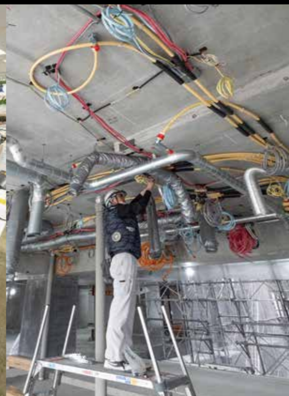
躯体工事が完了した低層階から配管などの設備工事が順次進む
