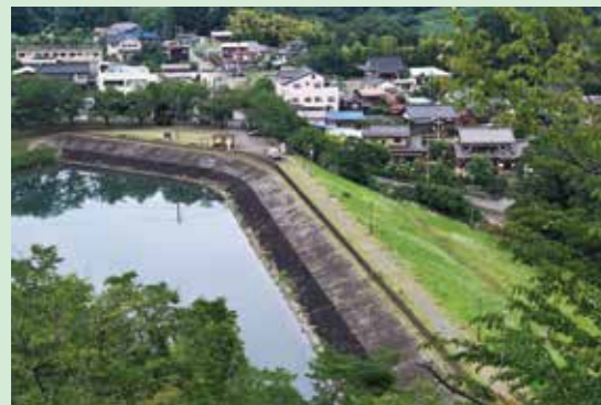
大野調整池は堰堤と制水門、余水路が重要文化財に指定された。堰堤となる大野ダムは粘土や土、砂礫などの土質資材によって築かれた大正期を代表するアースダムだ。電気の使用量が少ない夜間は水を貯め、昼間にはこの調整池に貯留した水を使って発電する
