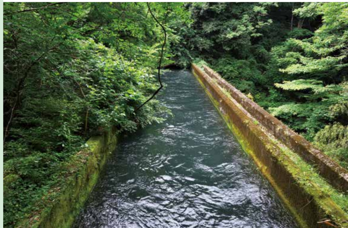
大野調整池は堰堤と制水門、余水路が重要文化財に指定された。堰堤となる大野ダムは粘土や土、砂礫などの土質資材によって築かれた大正期を代表するアースダムだ。電気の使用量が少ない夜間は水を貯め、昼間にはこの調整池に貯留した水を使って発電する
