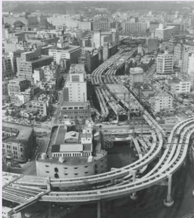
建設が進む1号線(提供:東京都)
