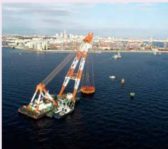
2021年12月に本誌で取材した岸壁築造工事の現場。岸壁の基礎部分となる「銅板セル」の設置状況(提供:東亜建設工業株)
