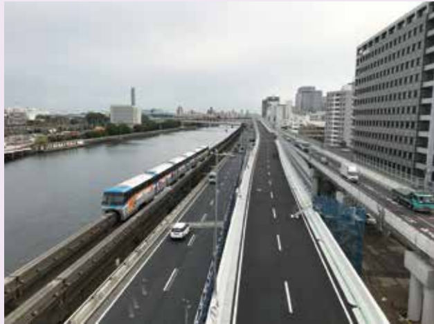
土木賞を受賞した首都高速1号羽田線東品川栈橋・鮫洲埋立部更新事業
