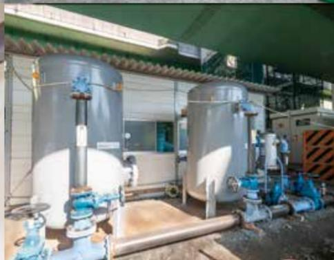
コンプレッサー(上)で圧縮された空気が空気清浄機(下)を経て、作業室内に送気される
