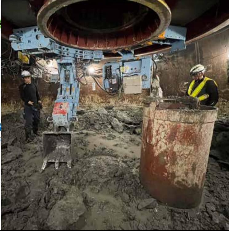
作業室内の掘削状況。水平方向の摩擦力など、基礎にかかる負荷を精緻に計測しながら掘削・沈設作業が行われる (提供：オリエンタル白石)
