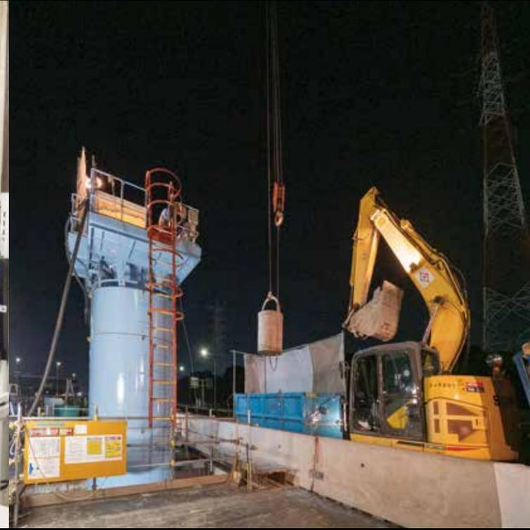
水色の筒状の装置がマテリアルシャフト。すぐ脇に横付けされたダンブ、バックホウ、土砂ピットが縦に並び、掘削土がリレーのように順番に移し替えられる
