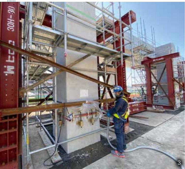
1. 営業線近接部の工事着手前(左JR・右えち鉄) 2. PCa柱部材搬入 3. PCa柱部材接合部へのモルタル注入 4. PCa高架橋構築完了
