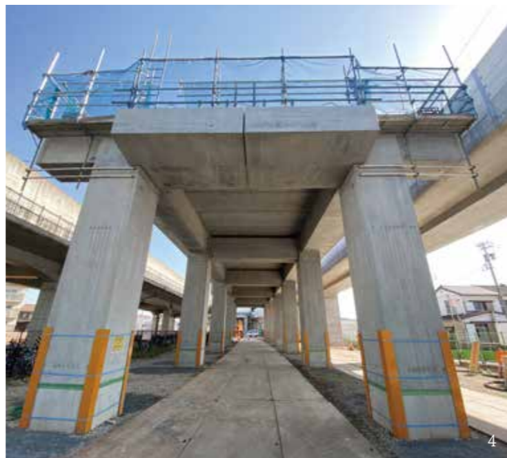
1. 営業線近接部の工事着手前(左JR・右えち鉄) 2. PCa柱部材搬入 3. PCa柱部材接合部へのモルタル注入 4. PCa高架橋構築完了
