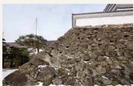
1592年頃に蒲生氏郷が築いた東北地方初の天守台。野面積み ※2 の古風な石垣で、勾配がきわめて緩い
