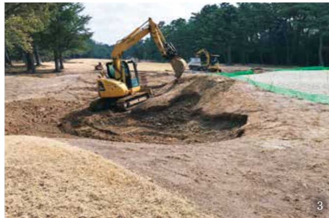
1. 完成後の8番ホール 2. 着工前の8番ホール 3.バンカー基盤の整形
