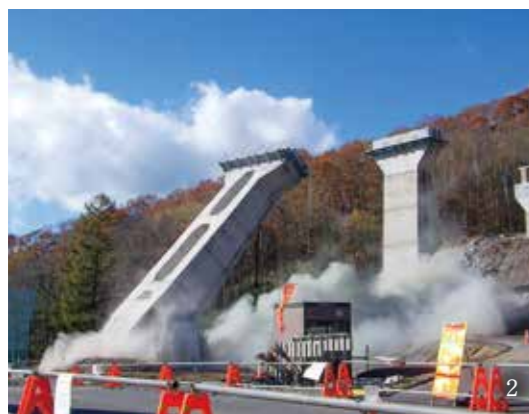
1. 既設橋PC桁の発破解体 2. 既設橋橋脚の発破解体 3. 土木学会選奨土木遺産 (P1～P2径間)
