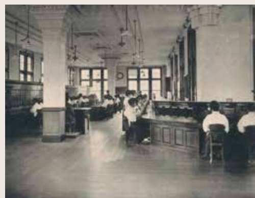
2階での電話交換業務は竣工当初、男性50人、女性185人が1日24時間3交代制で勤務していた。交換手は女性に限られ、高い職務能力と社会意識を身につけていることが求められていた。男性職員は主に電話線や機械の整備を担当した。2階床には荷上げ用の開口部が設けられていて、現在もその足跡を見ることができる(提供:菊池潤氏)
